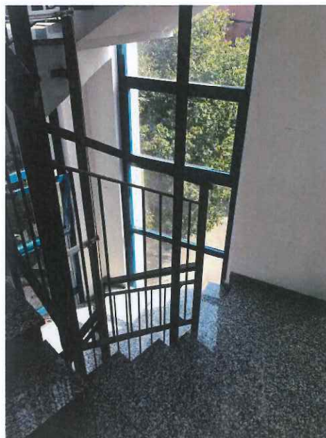
Foto 4 - vano scala comune
