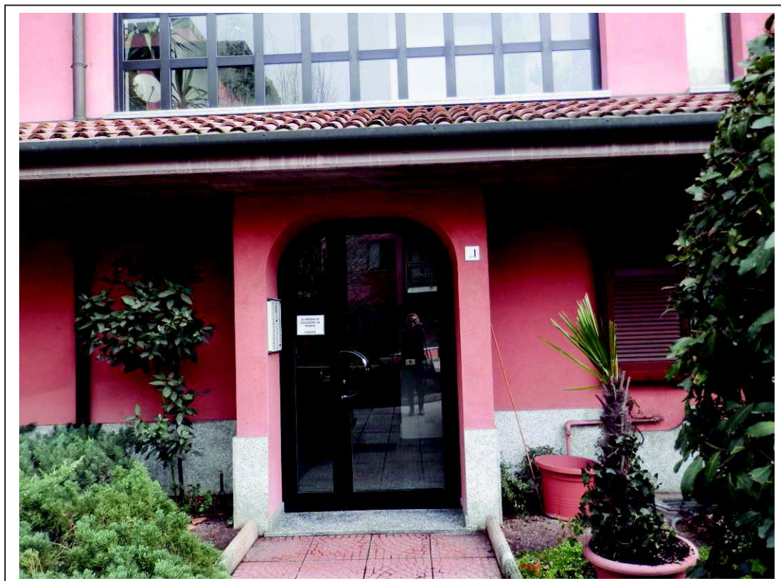
Fotografia n°4 – Vista della porta d'accesso al vano scala condominiale.
