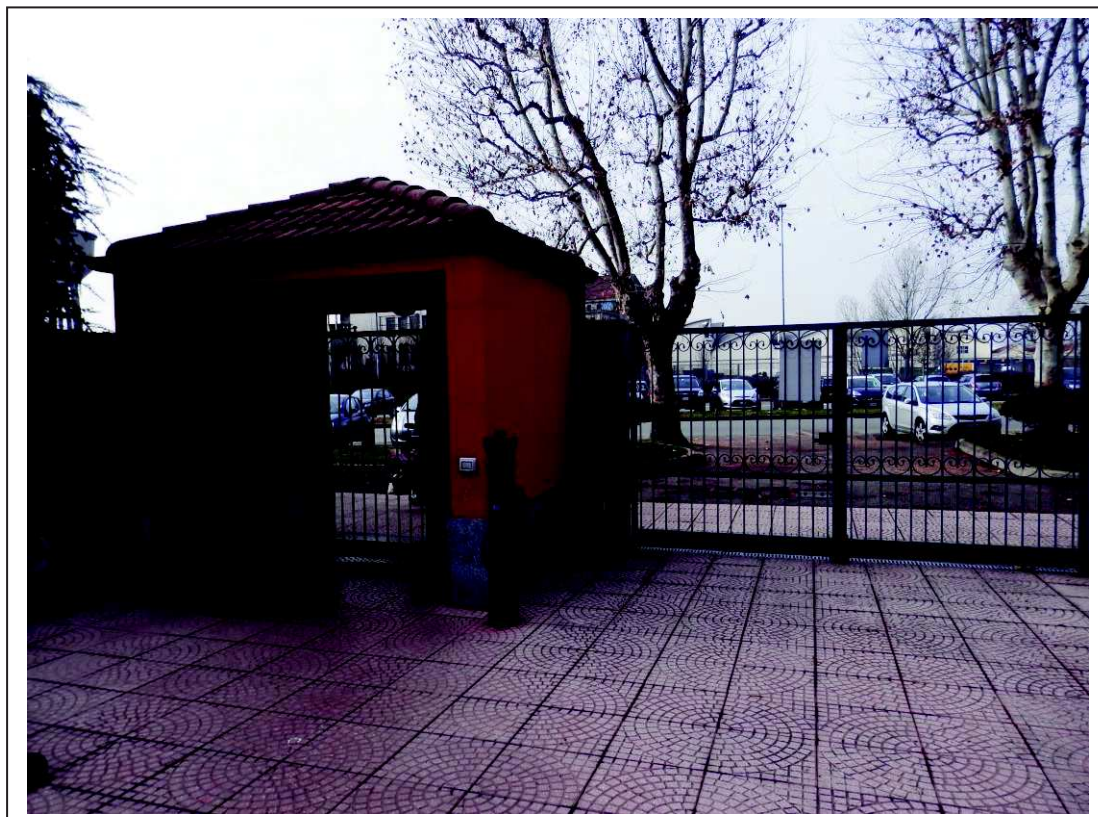
Fotografia n°2 – Vista dell'accesso carraio e pedonale al cortile interno comune.
