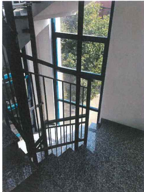
Foto 4 - vano scala comune
