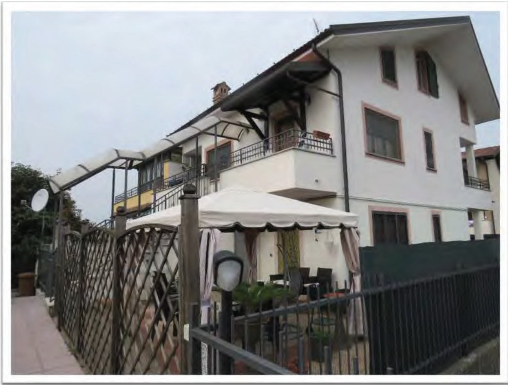
Particolare del lato Sud e della scala di accesso al piano 1°.
