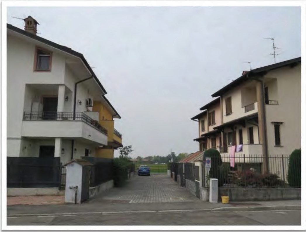
L'intorno verso Nord e particolare dell'accesso pedonale al condominio.
