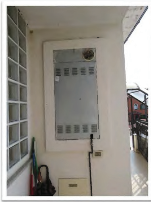
Particolare del vano tecnico e del percorso pedonale che conduce al piano interrato.
