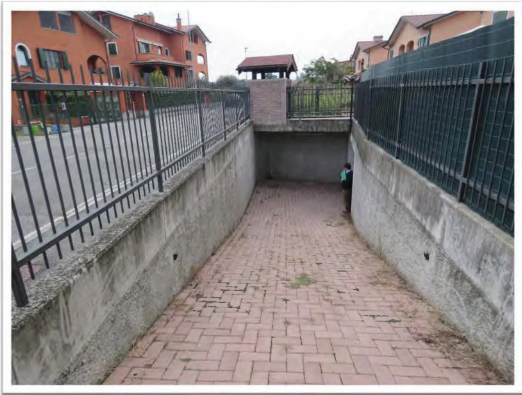
Rampa carraia ed accesso carraio da via Leonino.
