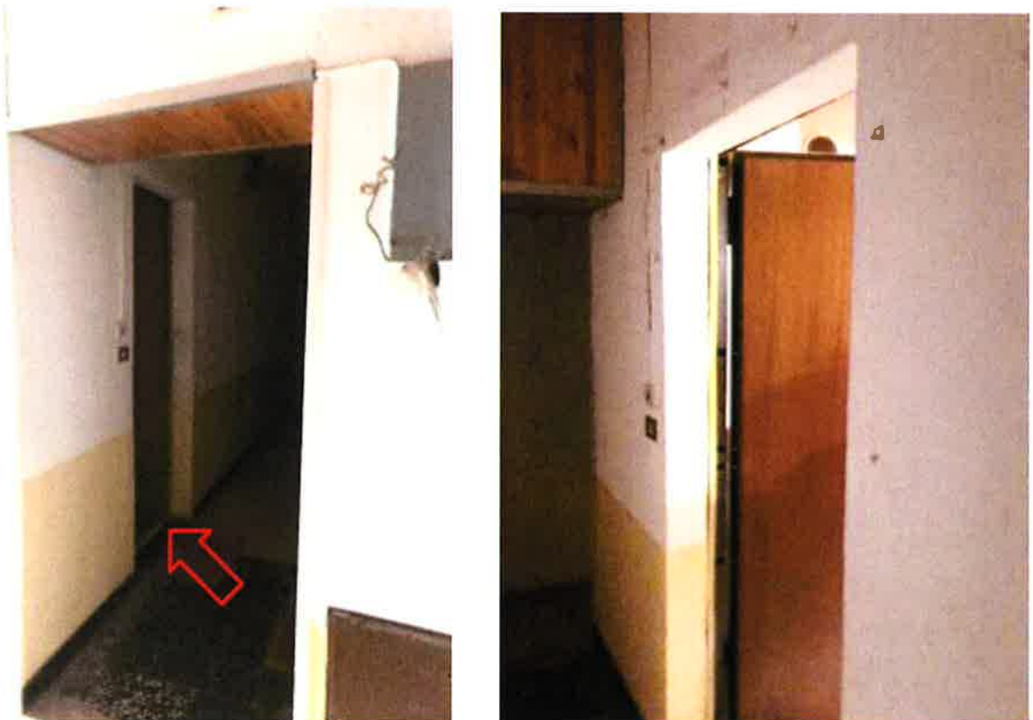
Vista pianerottolo d'accesso piano primo
