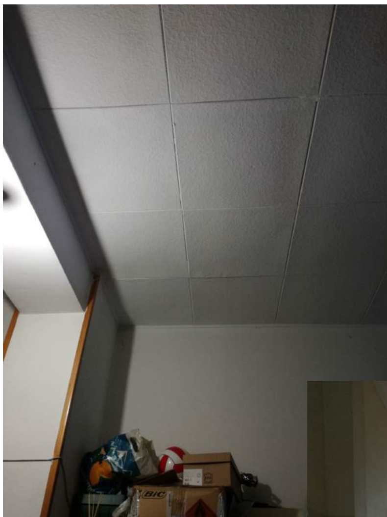
Foto 16, 17 – CONTROSOFFITTATURA E ANDRONE
