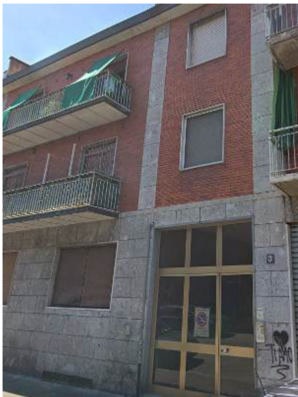
FOTO 1: MILANO, VIALE RAPISARDI 3, fronte dell'edificio
