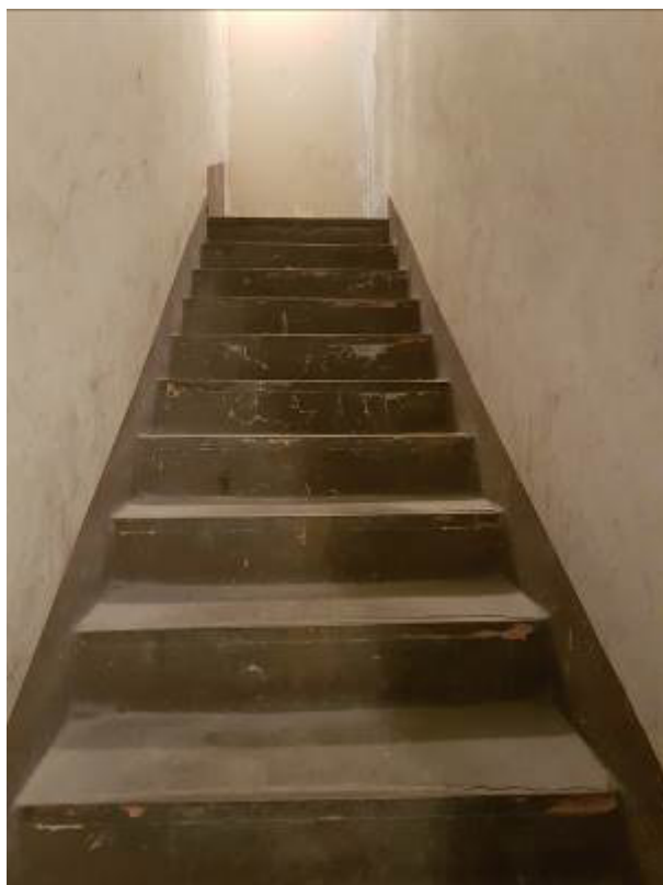
FOTO 14: MILANO, VIALE RAPISARDI 3, scale accesso cantina
