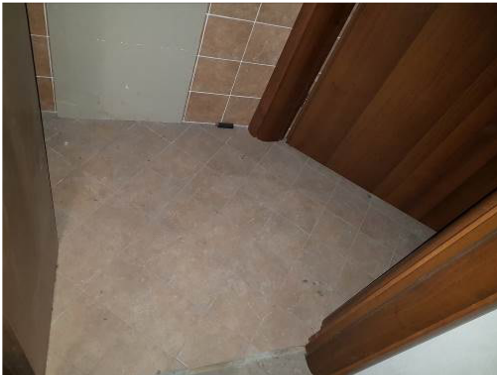
FOTO 9: MILANO, VIALE RAPISARDI 3, antibagno
