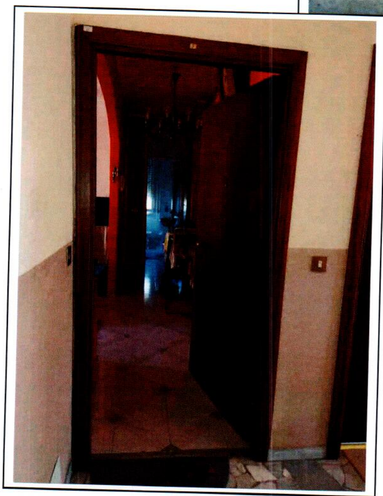
Fotografia n° 4 - Vista dell'ingresso all'unità immobiliare
