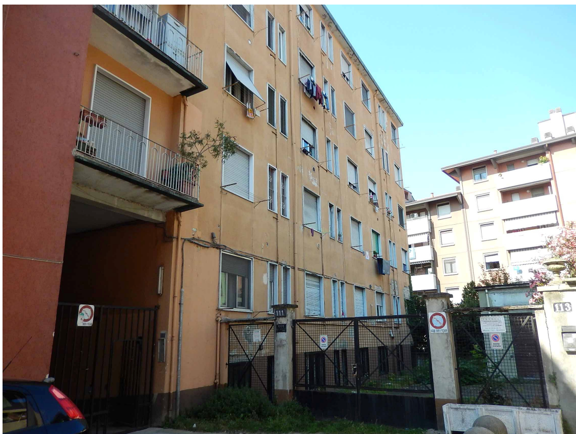
Foto 2 – Vista della facciata principale.
