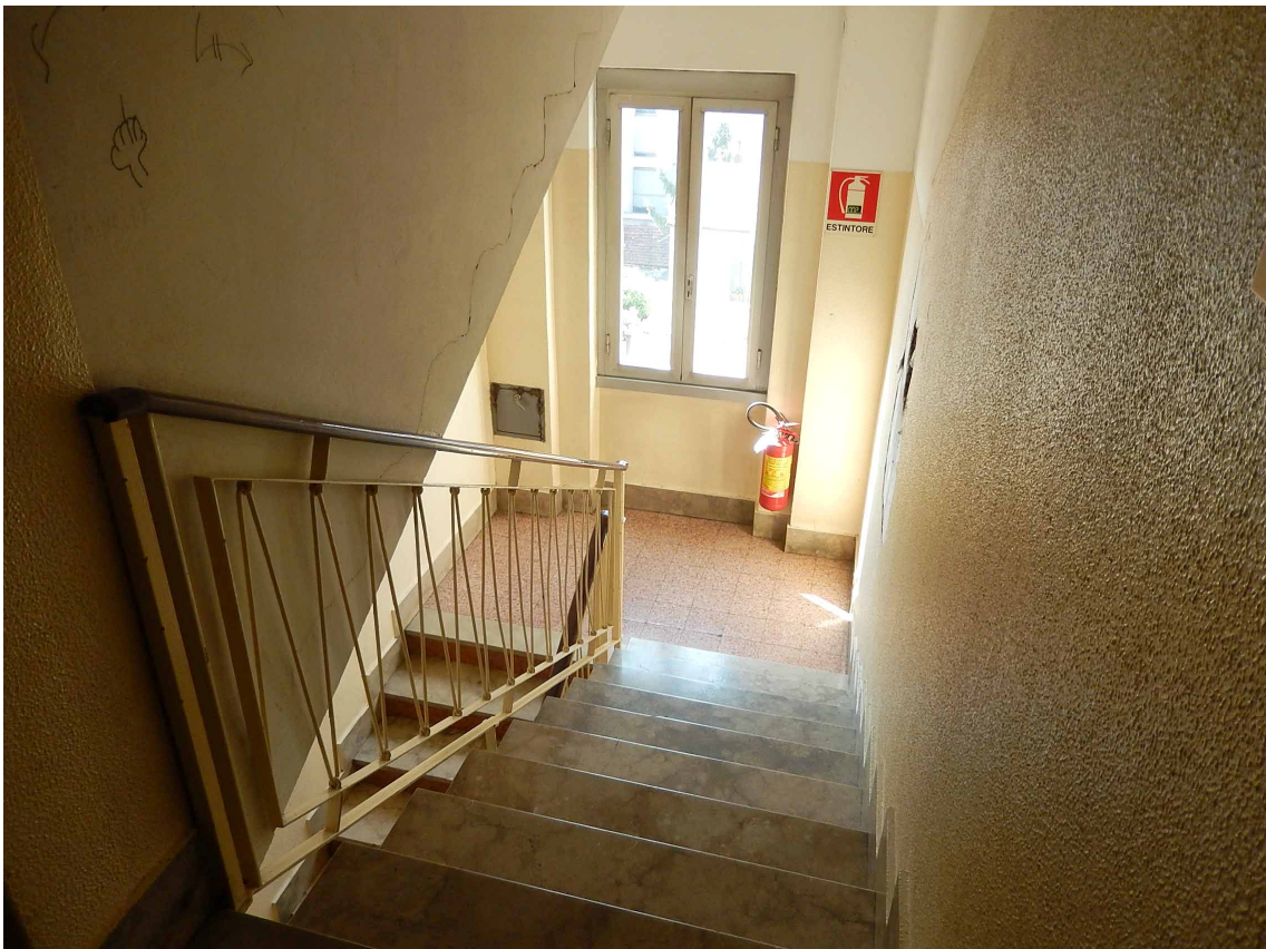
Foto 8 – Vista parziale del vano scala al piano quarto.
