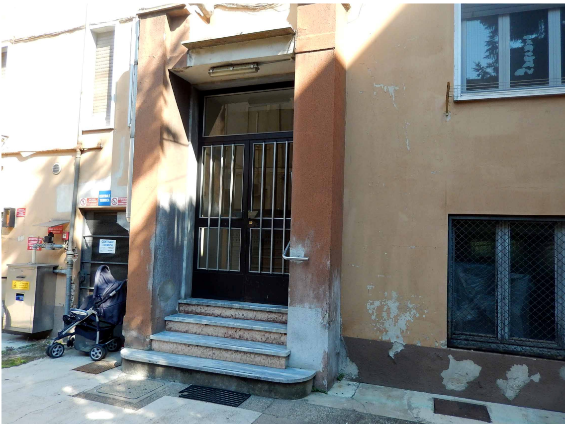
Foto 6 – Particolare Il portone di accesso al fabbricato.
