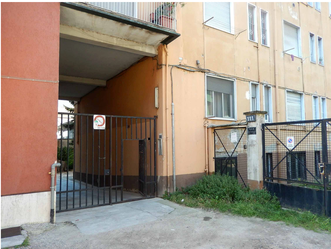
Foto 4 – Particolare del cancello esterno di accesso.
