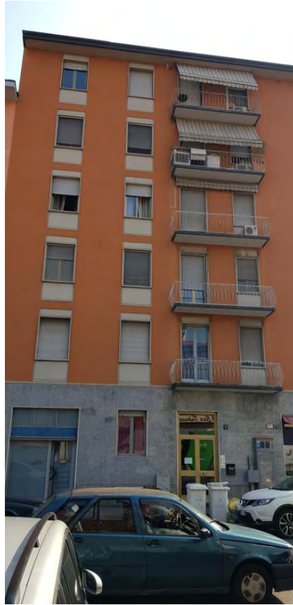
VISTA FRONTE SU VIA CASCINA BAROCCO – MILANO
