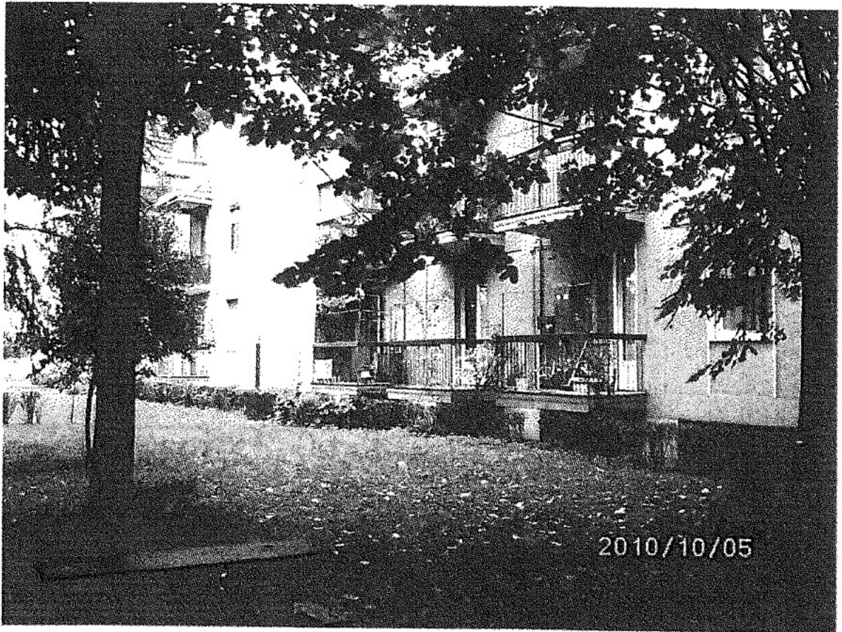
Foto 1 – Vista del retro dell'edificio con l'ampio giardino condominiale
