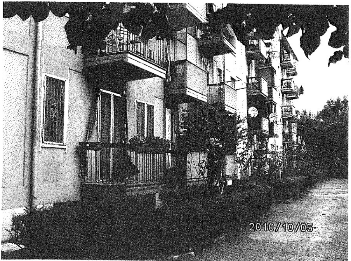
Foto 2 – Vista del fronte anteriore dell'immobile
