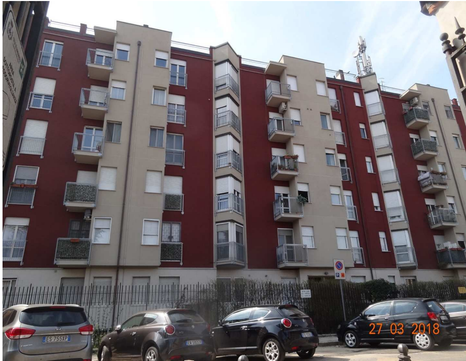
Vista esterna - condominio di riferimento
