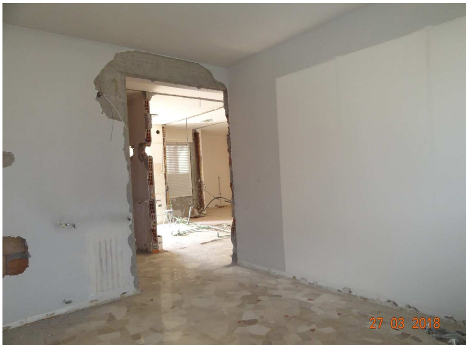
Vista interna - locale
