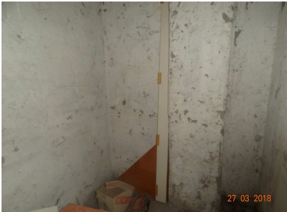
Vista interna - cantina
