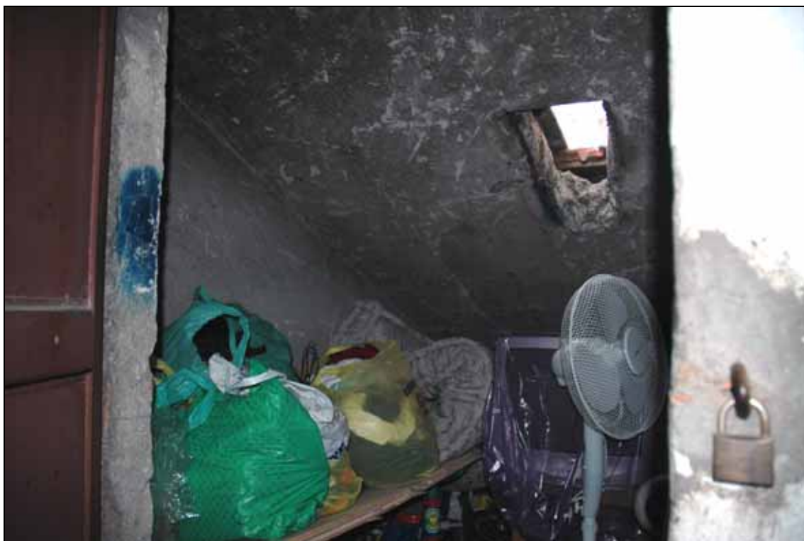
Foto 23 – Vista parziale del vano solaio di pertinenza.
