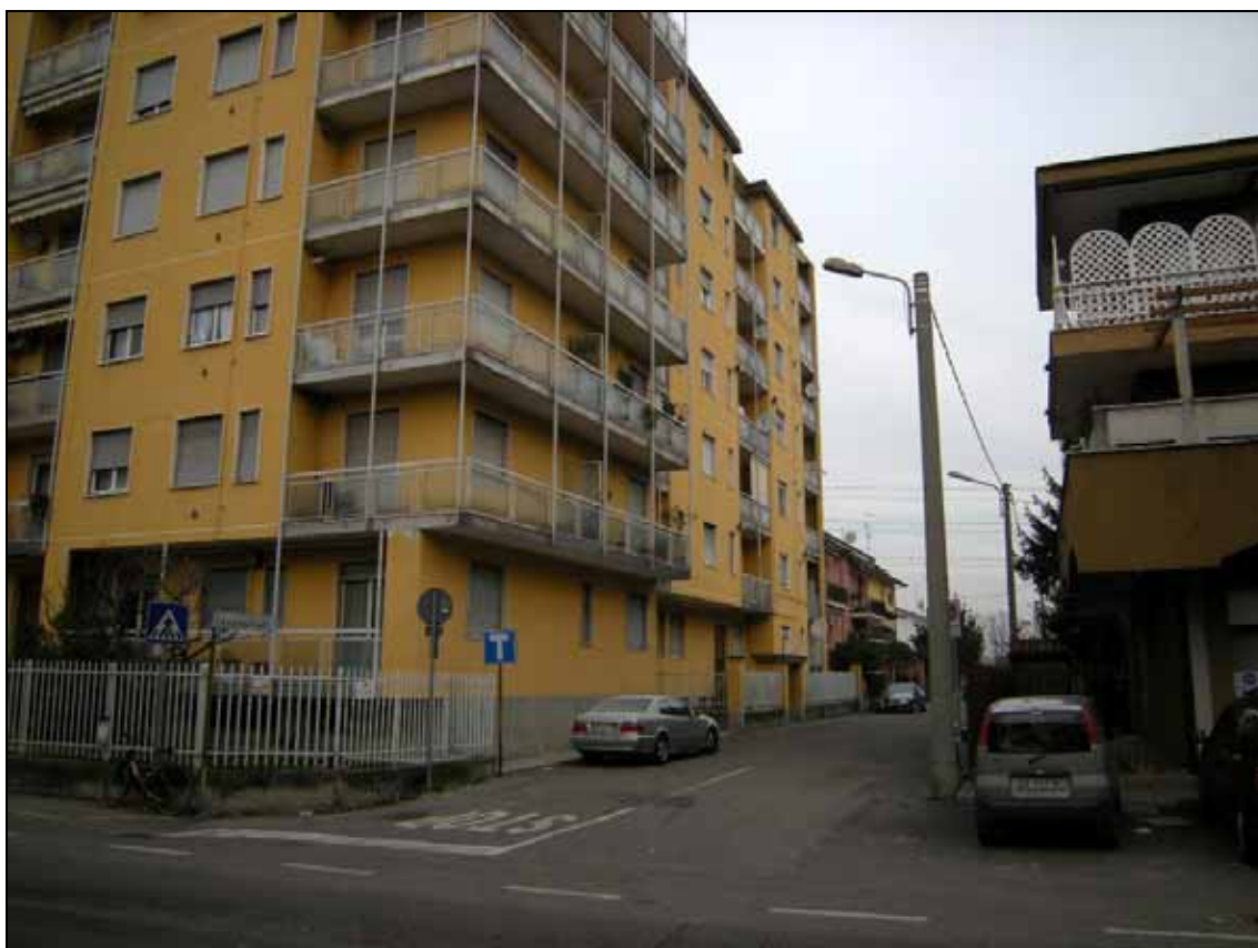
Foto 2 – La via Buonarroti all'angolo con la via Cavour.
