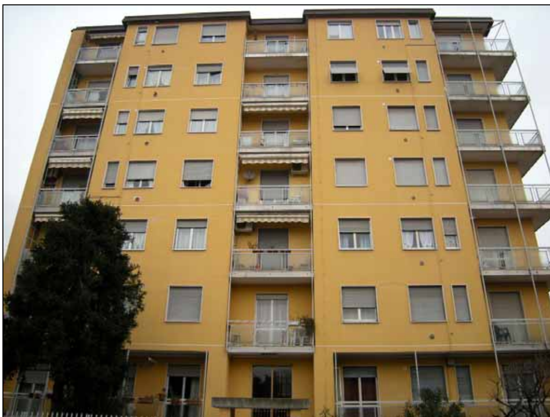
Foto 5 – La facciata sud sulla via Cavour.
