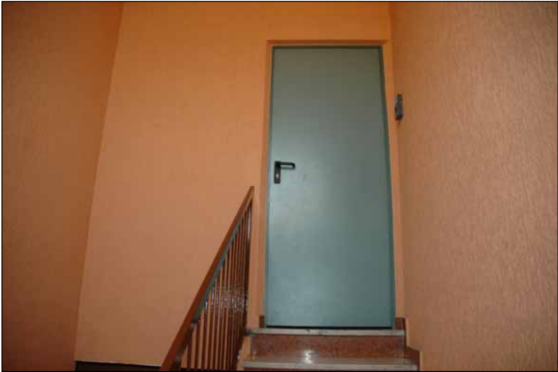
Foto 24 – La porta di accesso al piano sottotetto.
