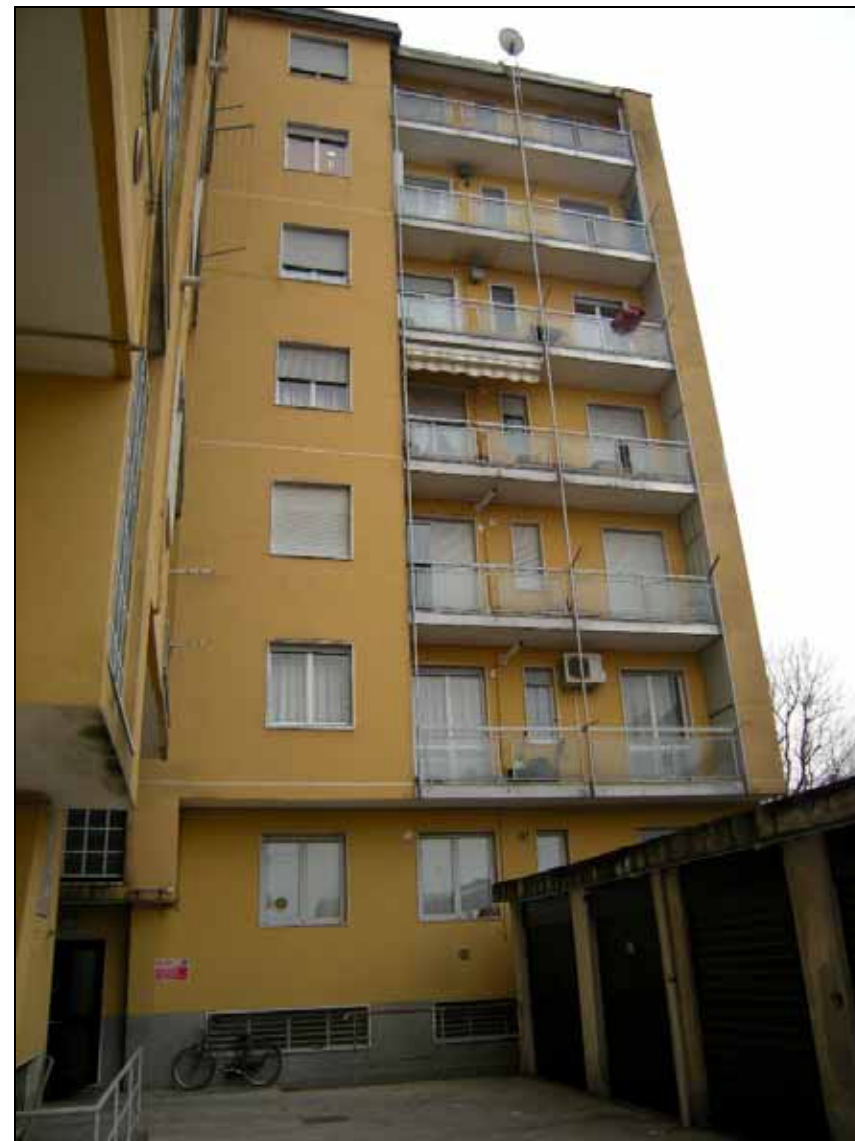
Foto 4 – La facciata interna.
