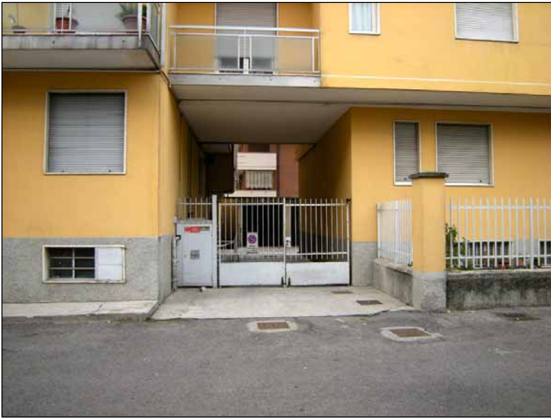
Foto 9 – Il cancello carraio sulla via Buonarroti.
