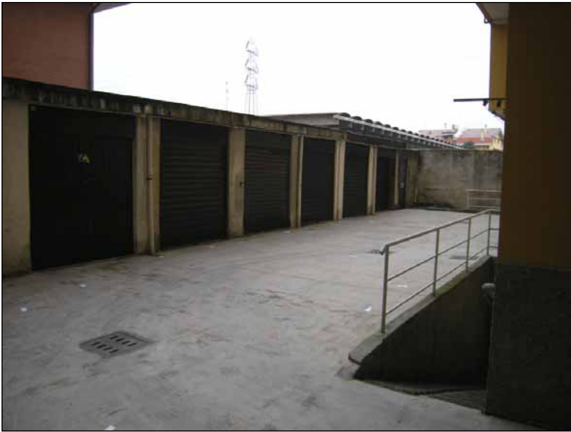
Foto 11 – Il corsello di manovra dei box.
