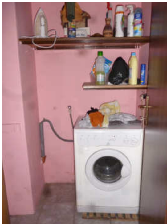
FOTO 8 – Particolare ripostiglio con attacco lavatrice
