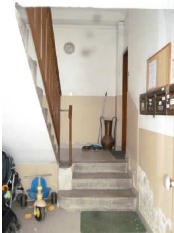
FOTO 3 – Androne di ingresso
