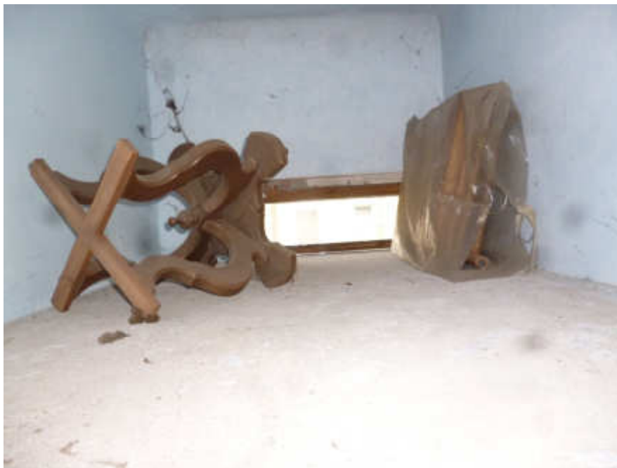
FOTO 14 – Particolare del controsoffitto finestrato sovrastante il locale bagno
