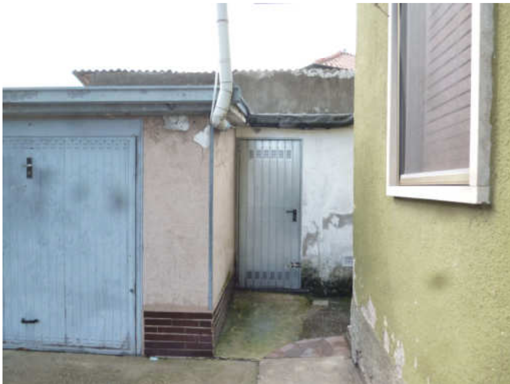
FOTO 16 – Posizionamento e porta cantina corrispondente all'unità B
