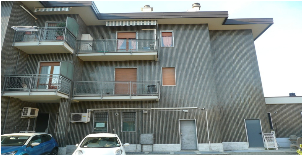
FACCIATA SU CORTILE INTERNO
