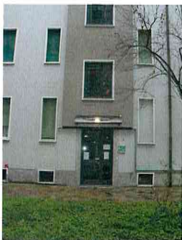
ingresso condominiale scala "H"
