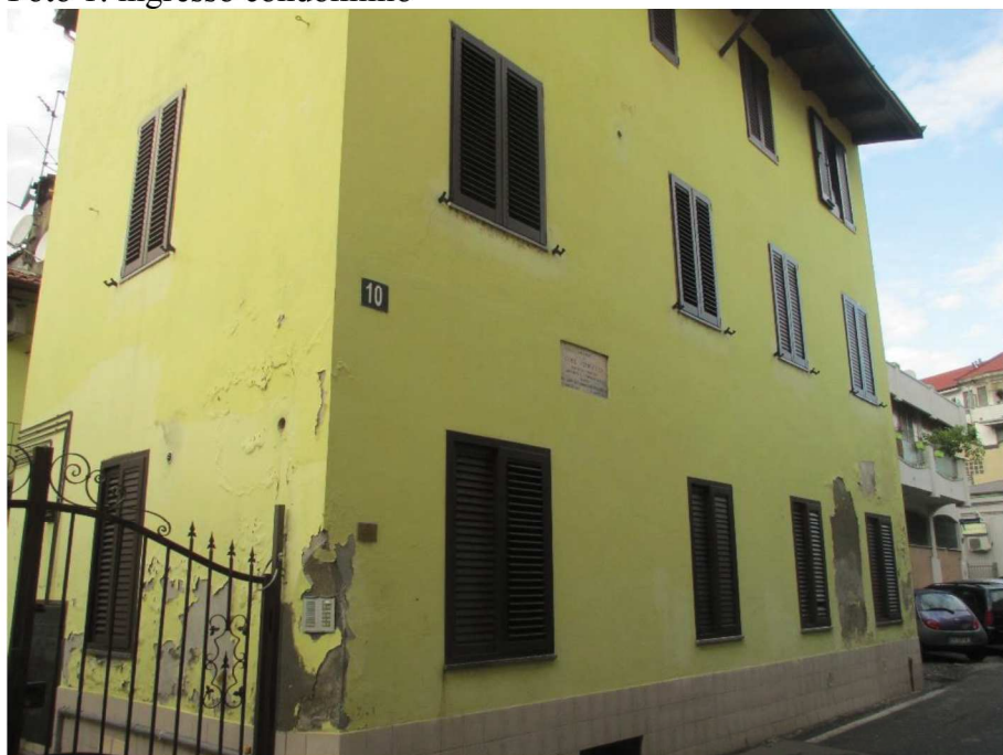
Foto 2: edificio via Catullo 10 Milano
