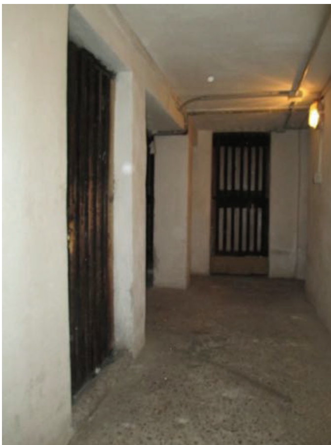
Corridoio di accesso e ingresso cantineantine
