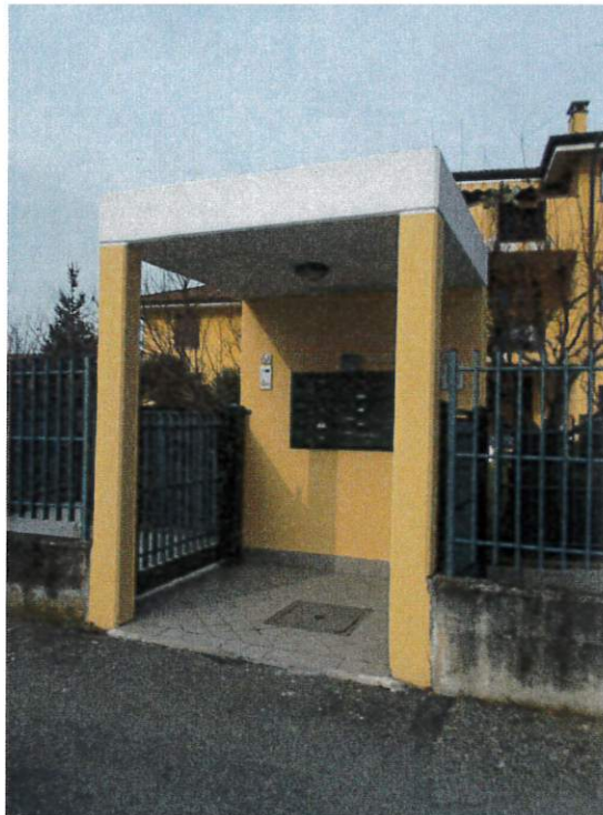
3. Portico di ingresso
