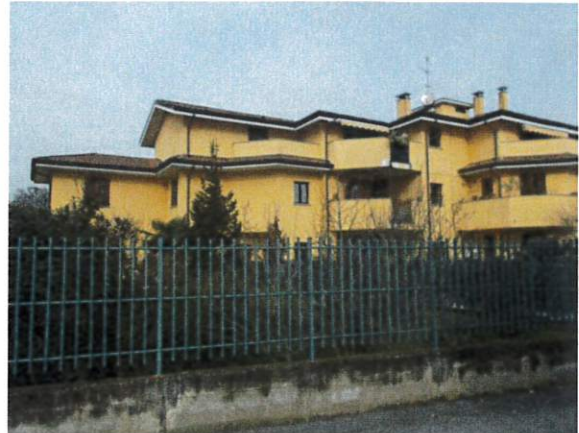
2. Panoramica del fabbricato
