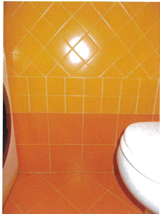
24. Dettaglio del rivestimento del bagno
