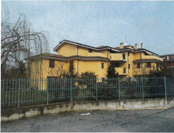
1. Panoramica del fabbricato
