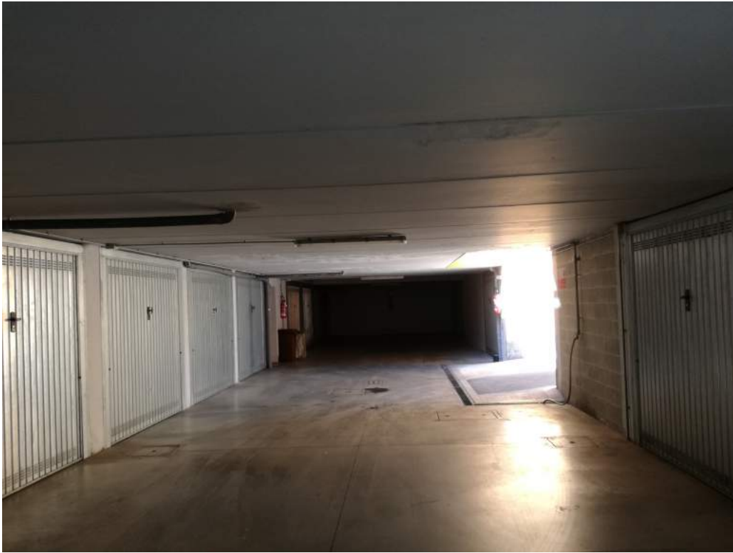
Foto 8-10 CORSELLO BOX – SCALE COMUNI – CORRIDOIO CANTINE
