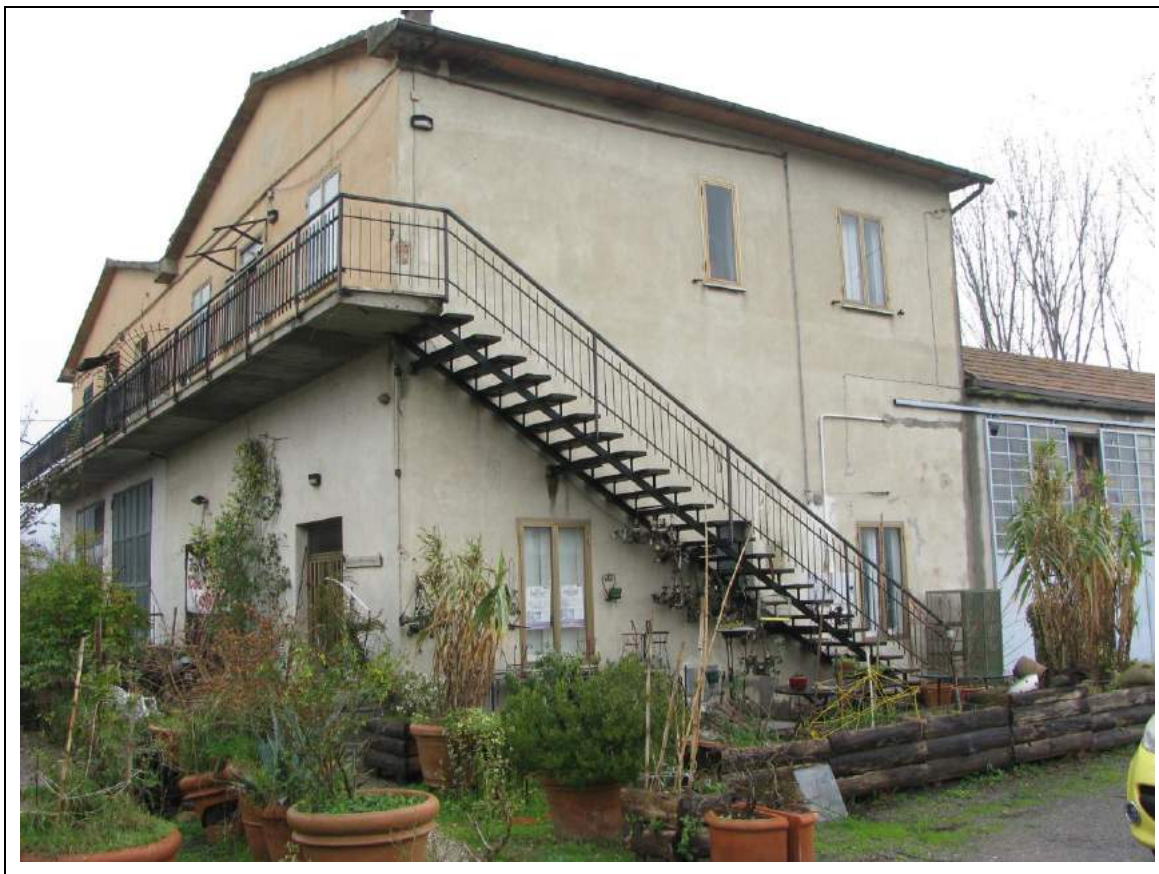
FRONTE SU STRADA PROVINCIALE
