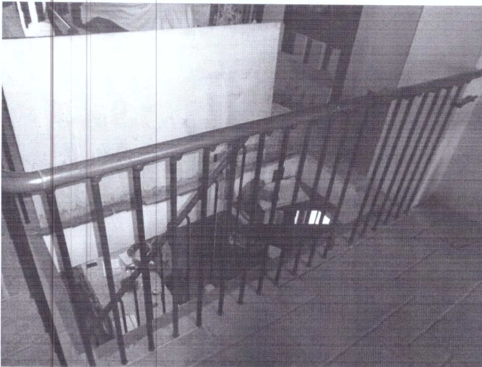
- FOTO 29 - VANO SOTTOTETTO 1 -
