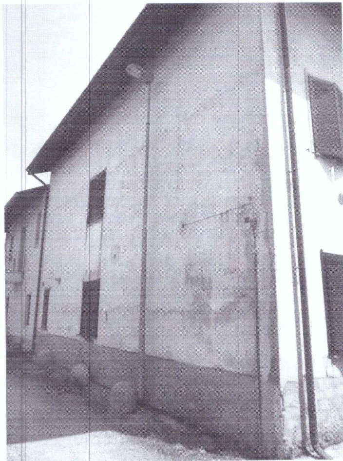
- FOTO 3 - FACCIATA NORD SU VIA SANTO STEFANO -
