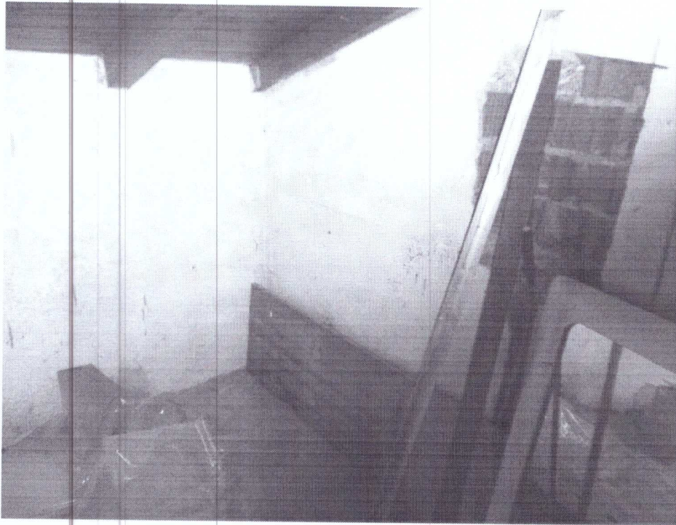
- FOTO 32 - VANO SOTTOTETTO 1 -
