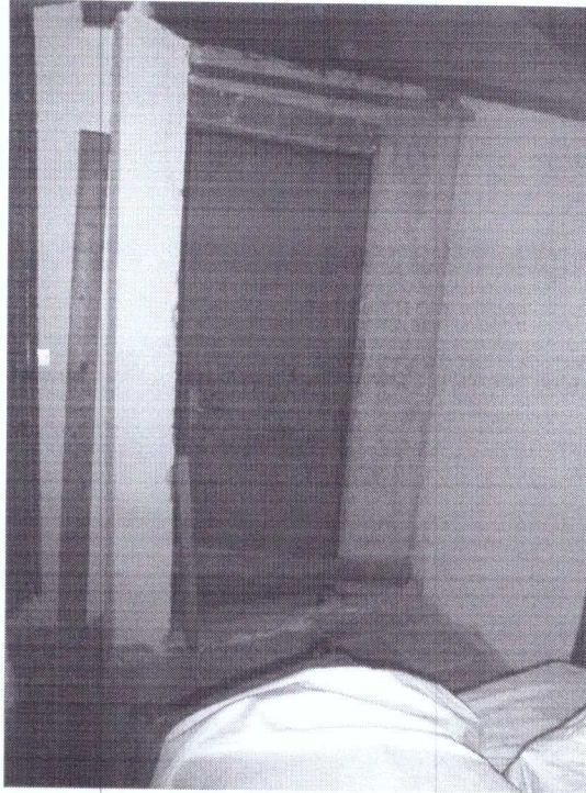
- FOTO 28 - VANO SOTTOTETTO 1 - DETTAGLIO PORTA COMUNICANTE CON VANO SOTTOTETTO 2 -
