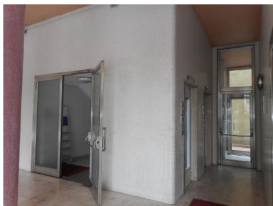
Vista dell'accesso al corpo scala di pertinenza dell'appartamento pignorato
