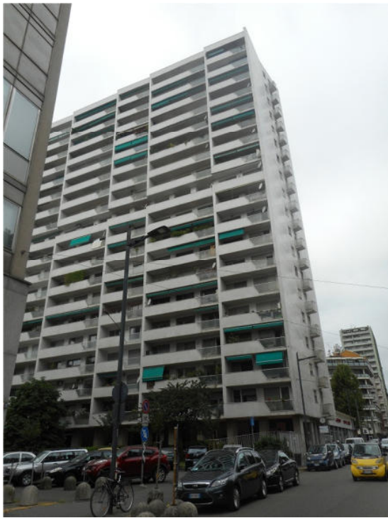
Vista di una delle due facciate dell'edificio in Corso Sempione 33
