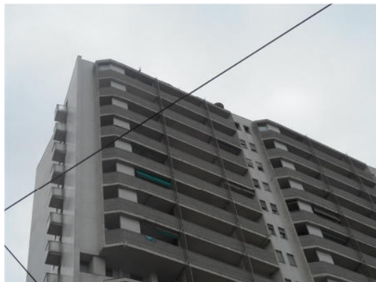
Vista degli affacci dell'appartamento pignorato
