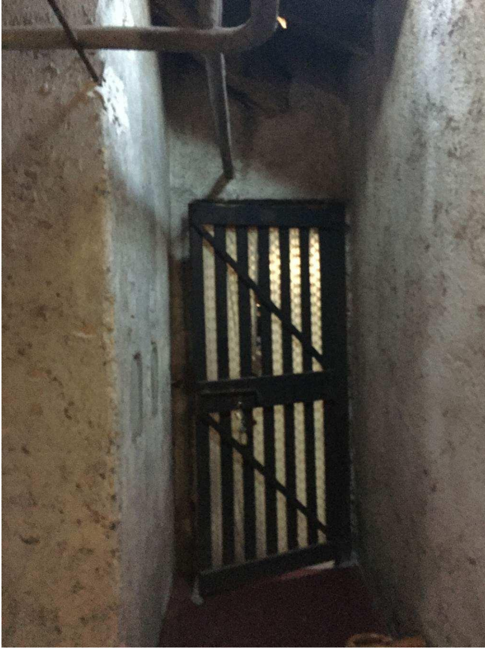
Fotografia n. 34 – Vista della porta di ingresso al solaio di proprietà del debitore, al piano sottotetto
