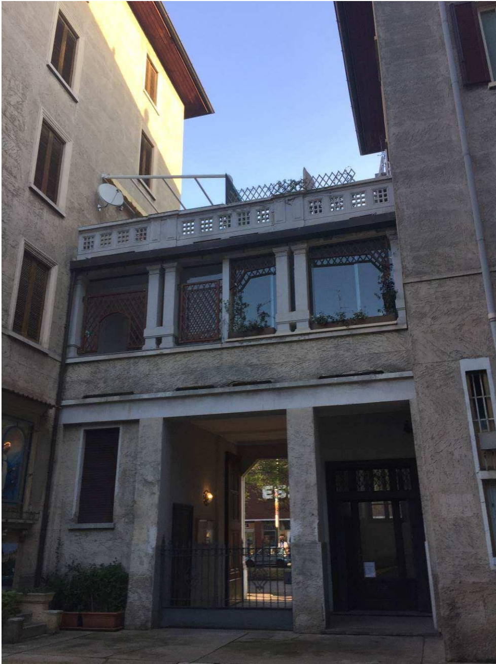
Fotografia n. 7 – Vista dal cortile interno dell'accesso pedonale e carroio al Condominio di Via Mac Mahon n. 111
