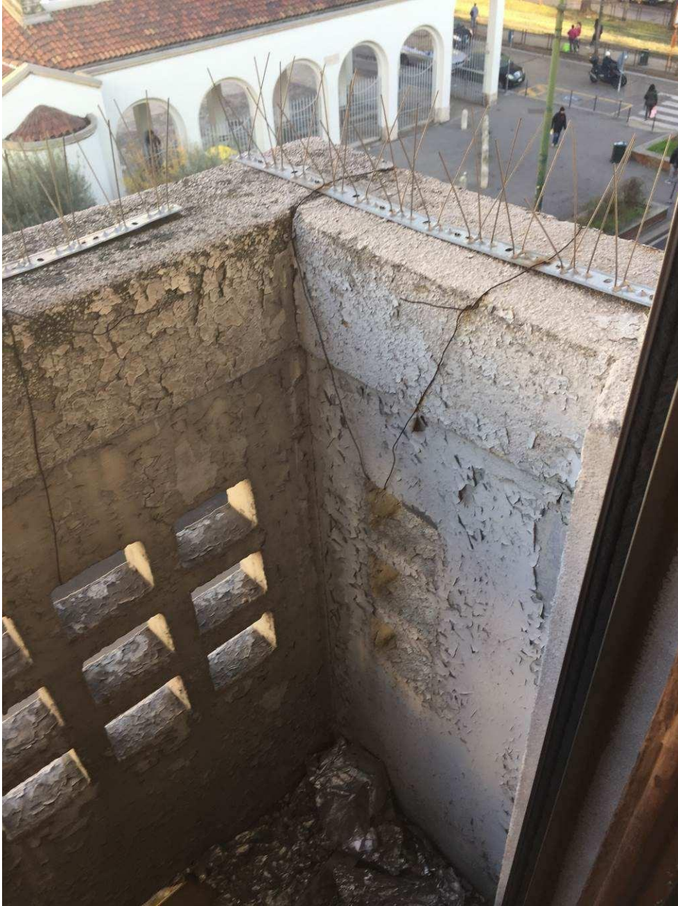
Fotografia n. 27 – Vista del balcone, che affaccia sulla Via Bramantino, a servizio del locale camera a due posti letto
