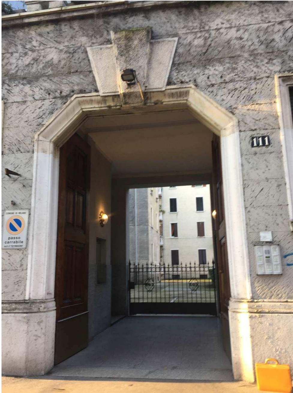
Fotografia n. 5 – Particolare del portone di accesso pedonale e carraio al Condominio di Via Mac Mahon n. 111, all'interno del quale si trova l'immobile staggito
