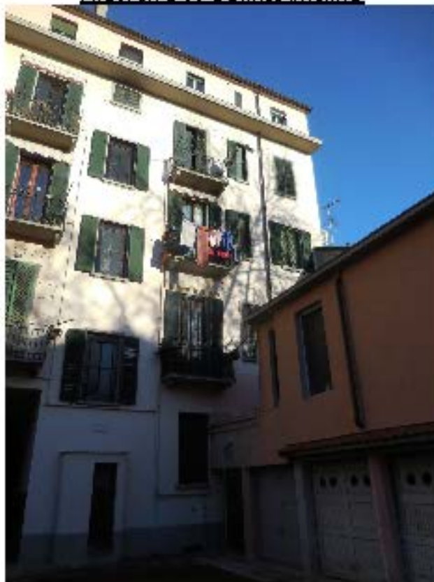
PROSPETTO SU CORTILE INTERNO
