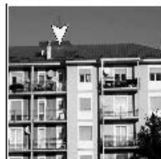
F. n. 3 - Dettaglio copertura
