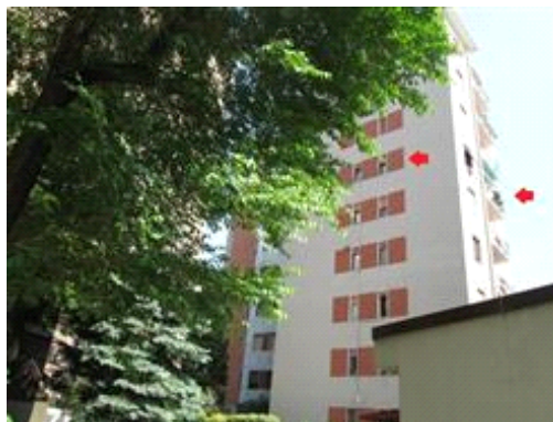
Facciata con identificazione appartamento
