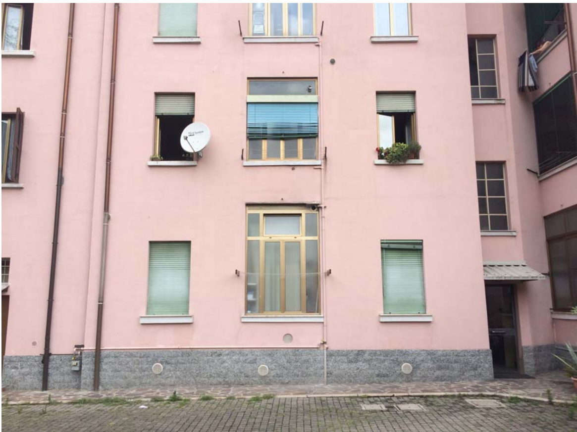
Foto 06 - Facciata del fabbricato (unità al primo piano)
