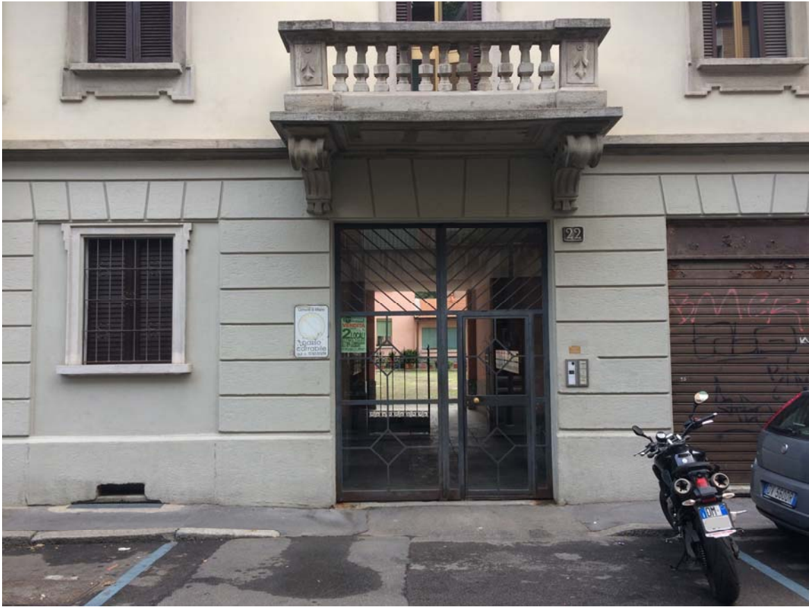
Foto 03 - Accesso al fabbricato al civico 22 di via Regaldi
