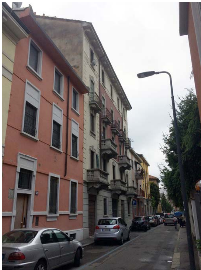
Foto 02 - Il fabbricato su via Regaldi
