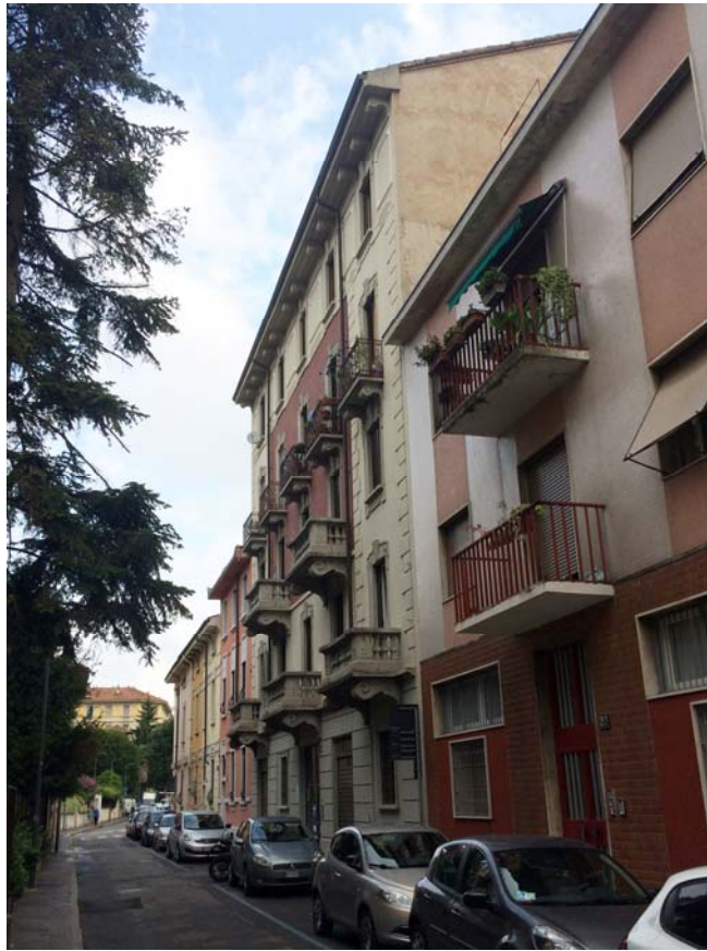
Foto 01 - Il fabbricato su via Regaldi
