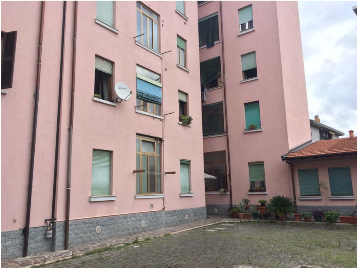
Foto 05 - Facciata del fabbricato sul cortile comune
