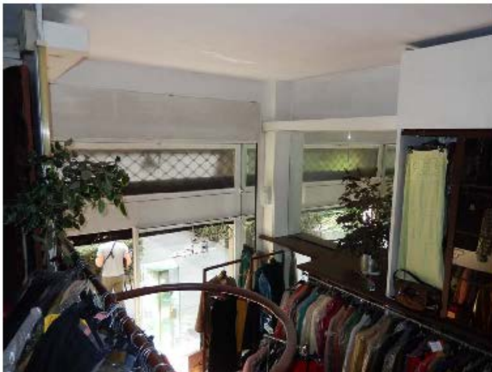
FOTO 9: Interno dell'unità pignorata – Scorcio dalla zona soppalcata.
