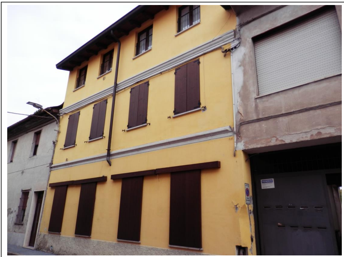
Fotografia n°1 – Vista della facciata del fabbricato su Via Mameli.
