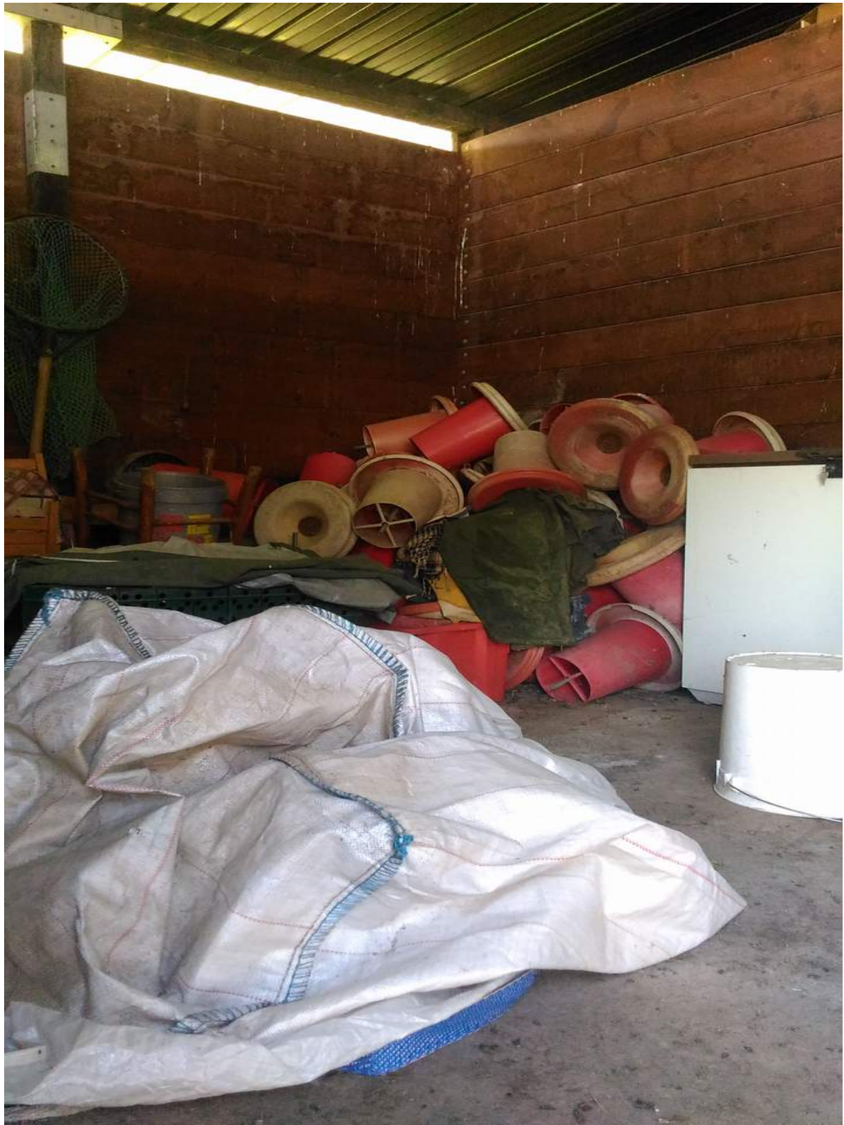
Foto n° 4 - 21/03/2018 - Comune di Pasiano Di Pordenone, foglio 40, part. 29-166-412 sub.1 - Fabbricato con struttura in legno e platea in cemento precedentemente utilizzato come ricovero per equini. Interni.
