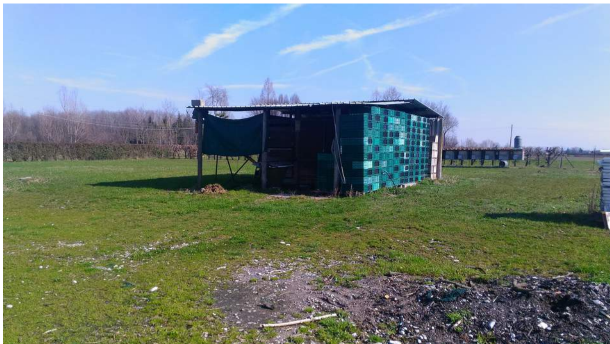
Foto n° 2 - 21/03/2018 - Comune di Pasiano Di Pordenone, foglio 40, part. 29-166-412 sub.1 - Fabbricato con struttura in legno e platea in cemento precedentemente utilizzato come ricovero per equini.
