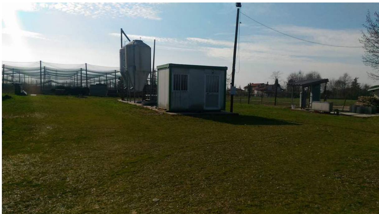
Foto n° 5 - 21/03/2018 - Comune di Pasiano Di Pordenone, foglio 40, part. 29-166-412 sub.1 - Visione d'insieme della particella 166. Sullo sfondo visibile la struttura adibita a voliera e descritta in relazione.
