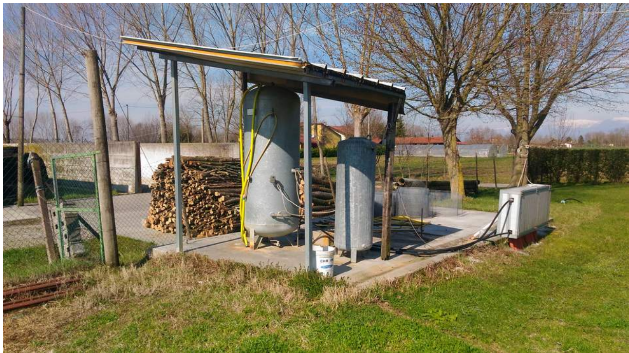
Foto n° 8 - 21/03/2018 - Comune di Pasiano Di Pordenone, foglio 40, part. 29-166-412 sub.1 – Struttura adibita al prelievo/pompaggio dell'acqua.
