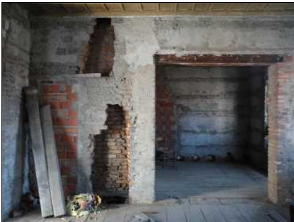
Piano primo – monolocale vano di collegamento con l'unità immobiliare adiacente (Sub. 702)
