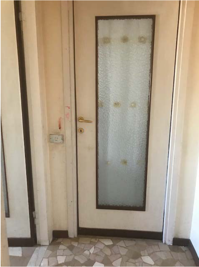
Figura 11 Dettaglio porte interne
