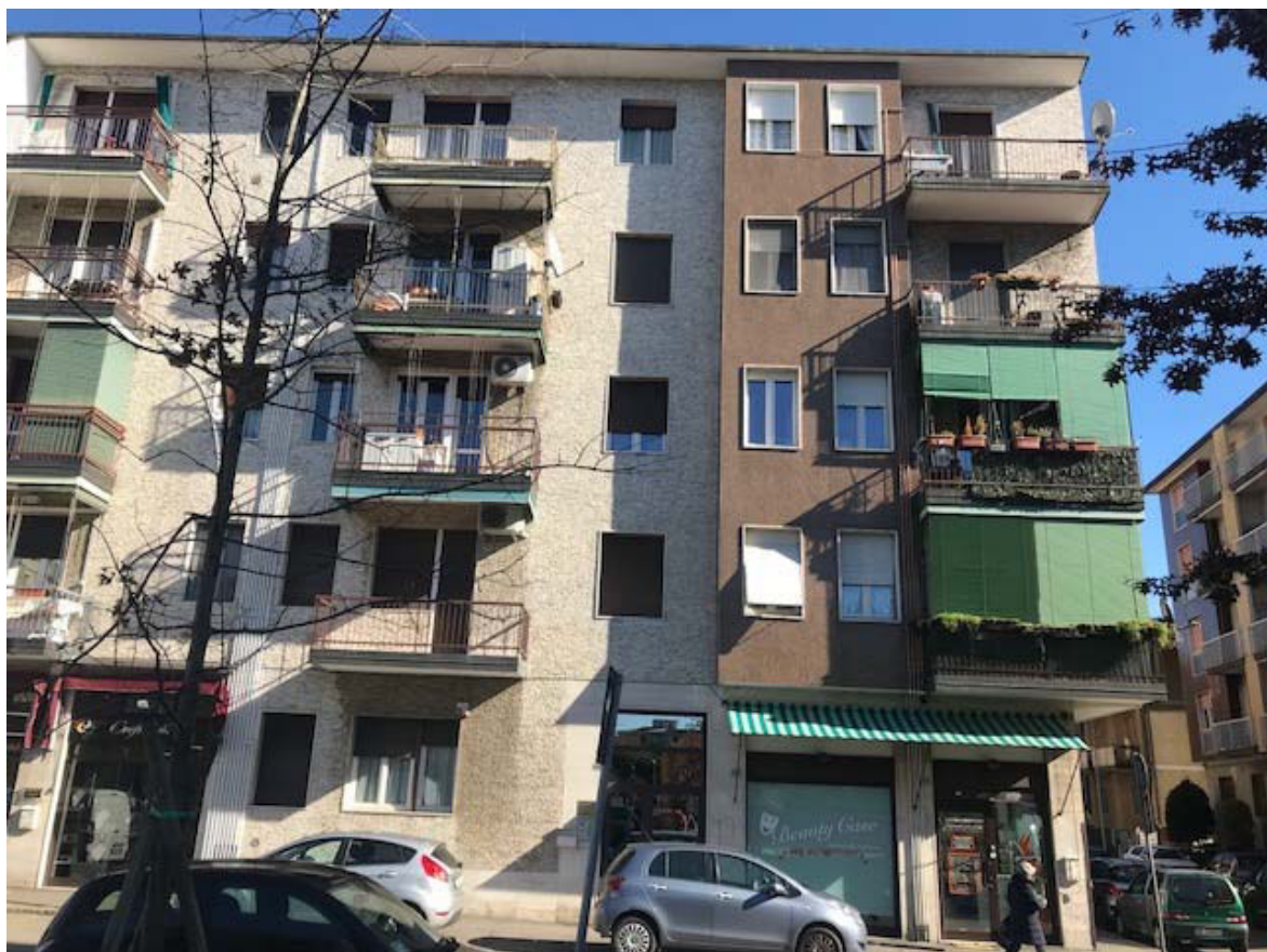
Figura 2 Porzioni di Edificio al civico n. 45
