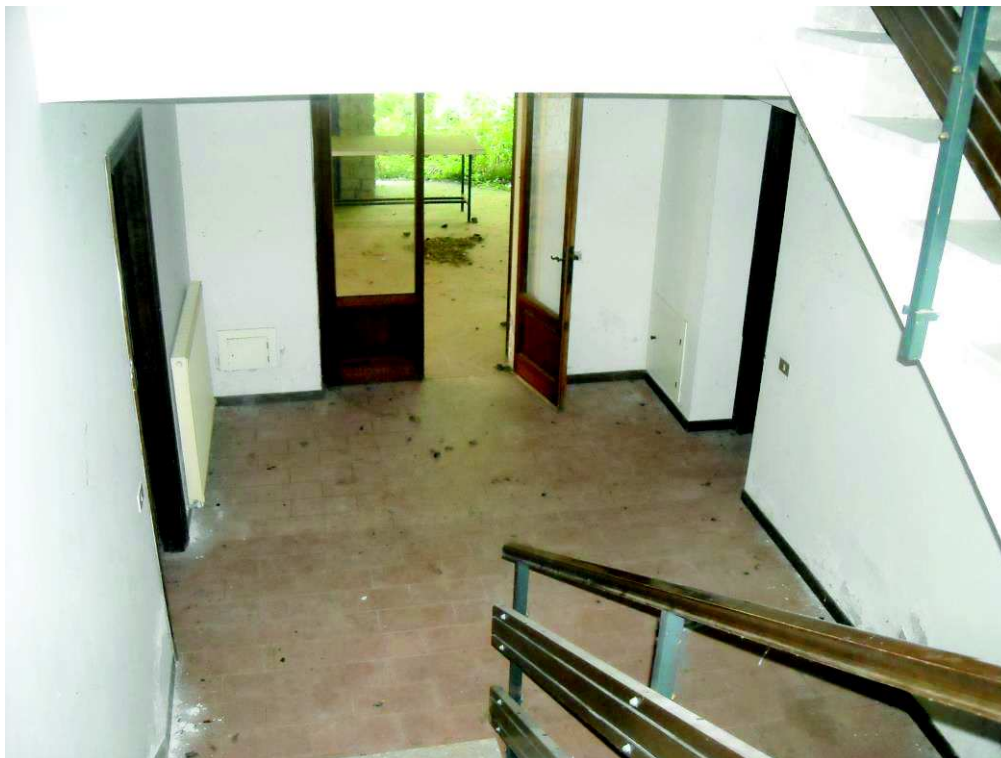
IL VANO SCALA VISTO DALL’INTERNO-
