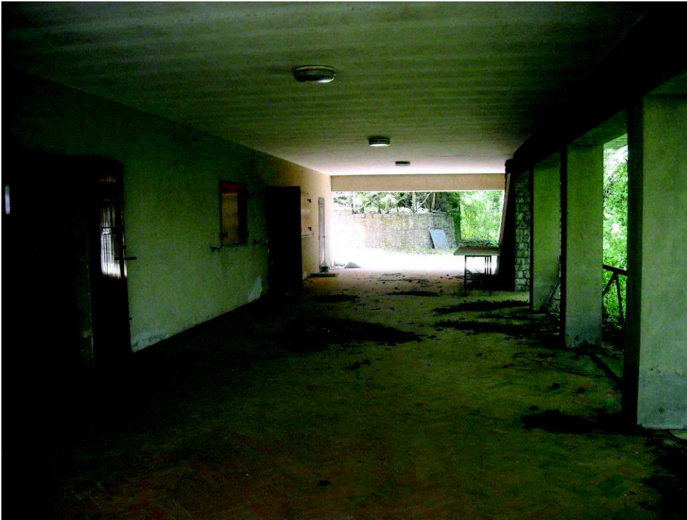
VISTA DEL PORTICO –LA PRIMA PORTA FINESTRA VISIBILE E LA FINESTRA SONO DEL SUB 5 LA SECONDA , CON L’ANTA APERTA , CONDUCE AL VANO SCALA (SUB 6 –BENE COMUNE NON CENSIBILE)
