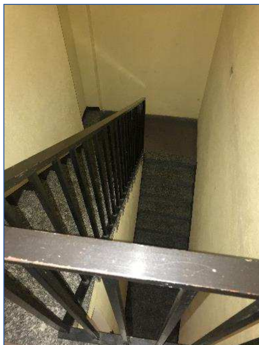
Foto 4 – Vano scala comune
