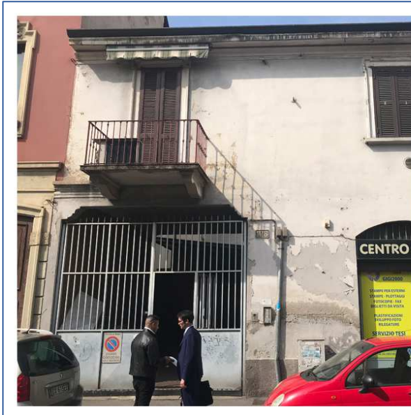
Fig. 3: Ingresso comune all'immobile
