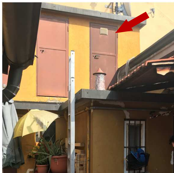
Fig. 9: Ingresso al ripostiglio
