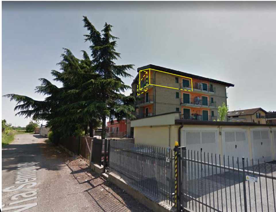
Foto n. 2: Facciate a Nord-Est
