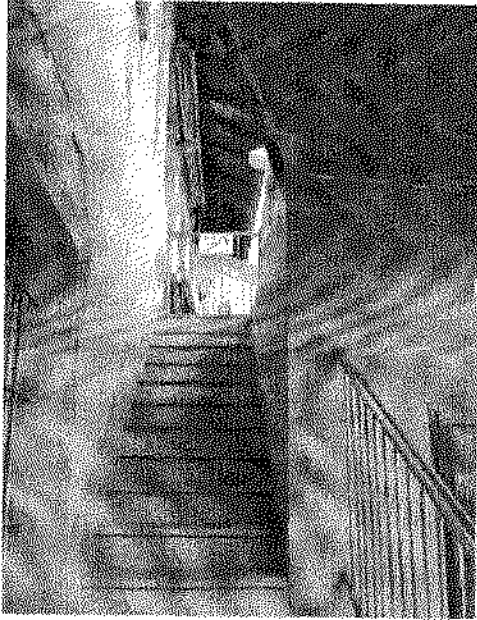
Scala di accesso al piano
