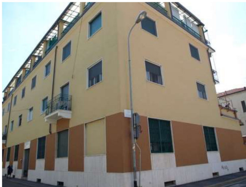
EDIFICIO VIA XX SETTEMBRE 19 - CORSICO
