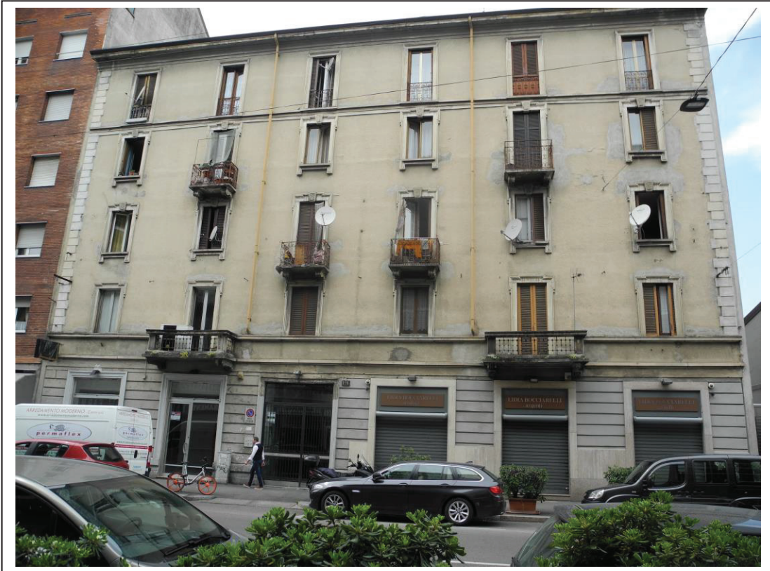
Fotografia n°1 – Vista del fabbricato residenziale da Via Padova.
