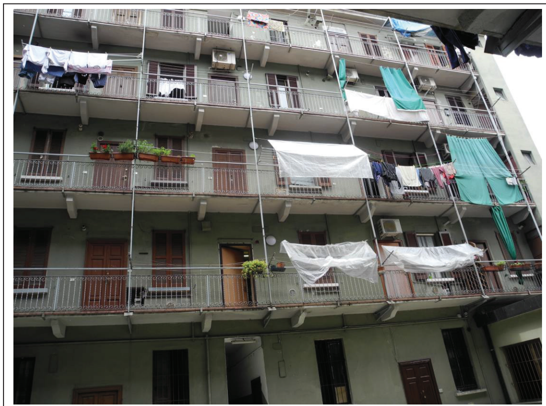
Fotografia n°2 – Vista della facciata del fabbricato rivolta sul cortile interno.
