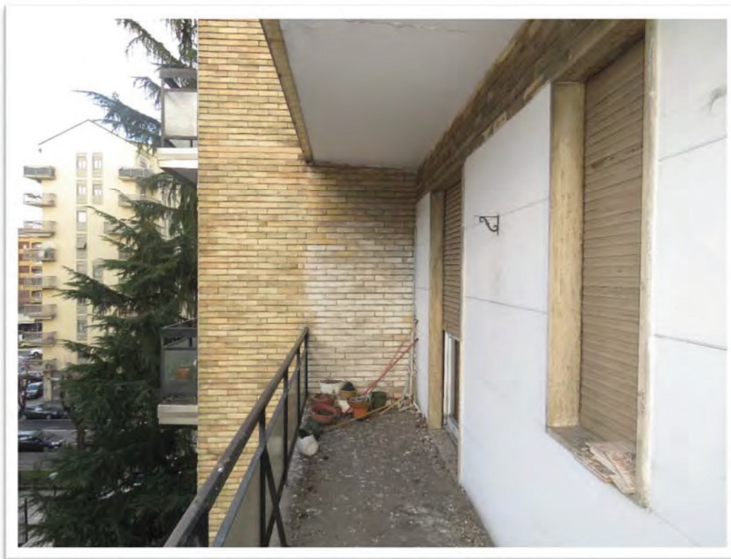
Balcone principale e particolare.
