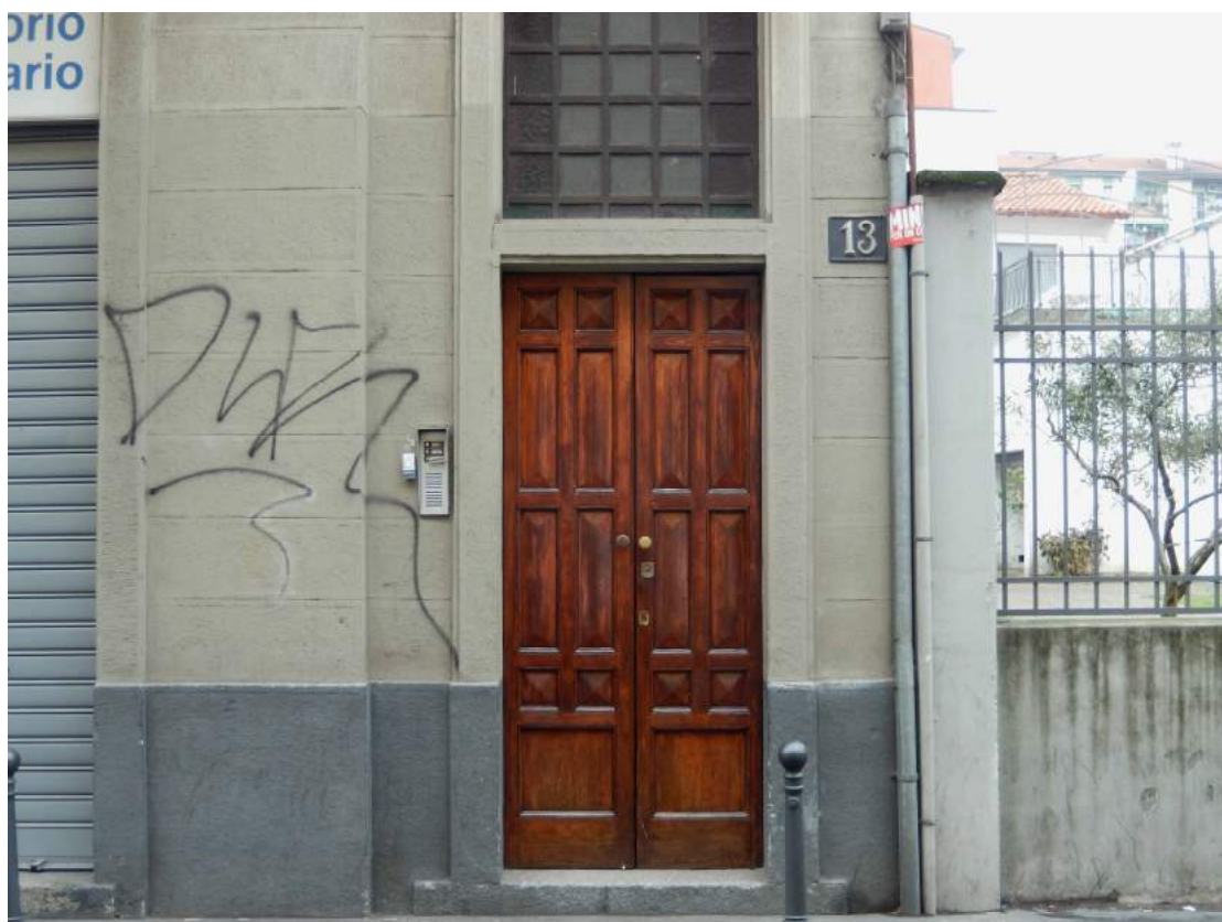
Foto 3 – Il portone d'ingresso all'edificio.
