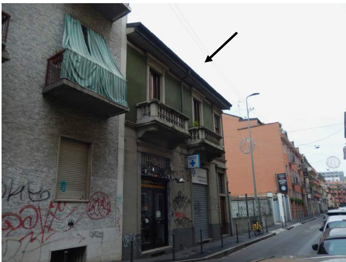
Foto 2 – La facciata su strada del fabbricato in esame.
