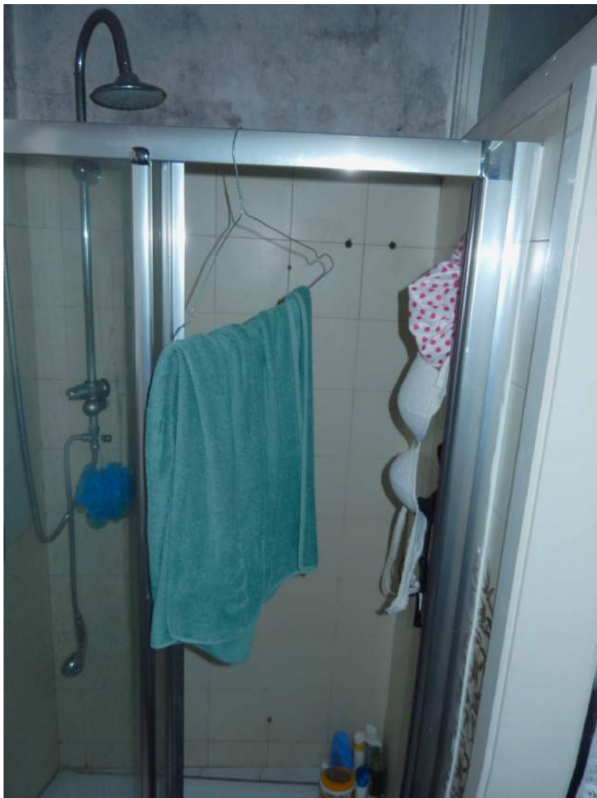
Foto 13 – Vista parziale del locale doccia.
