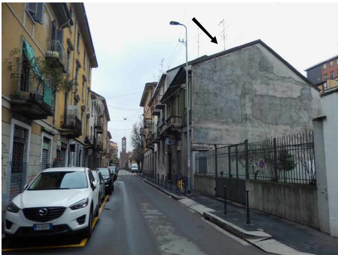
Foto 1 – Vista della via Conte Rosso. Sulla destra, il fabbricato in esame, indicato dalla freccia.
