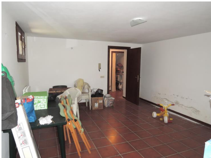
altro vano principale del piano seminterrato autorizzato come Sgombero
