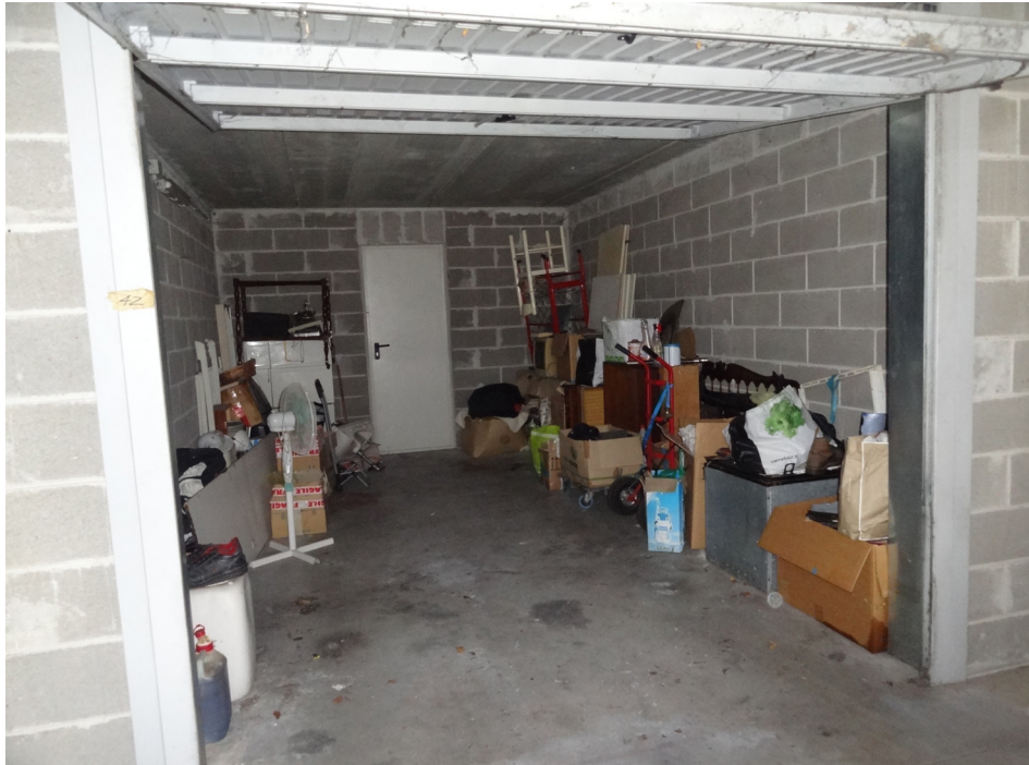
Vista interna - box
