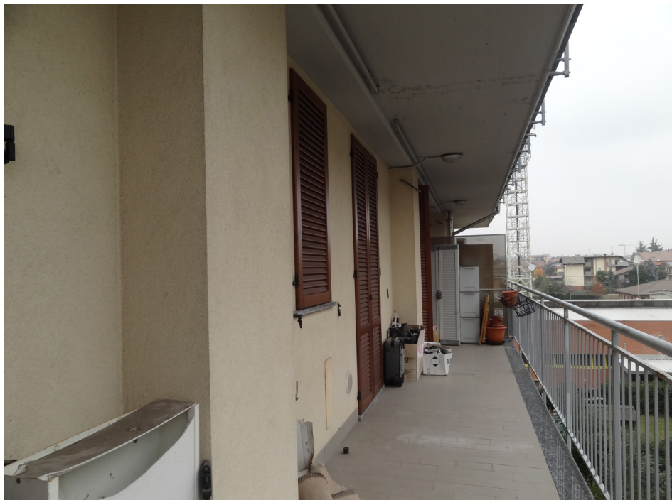
Vista esterna - balcone
