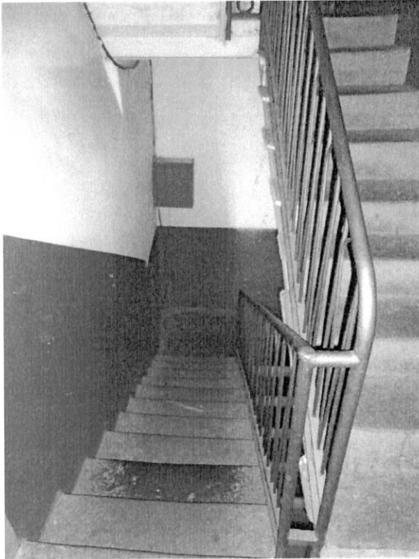
Particolare del vano scala comune per il collegamento ai piani del compendio immobiliare; gradini in pietra naturale e pavimentazioni in graniglia di cemento e inerti.
