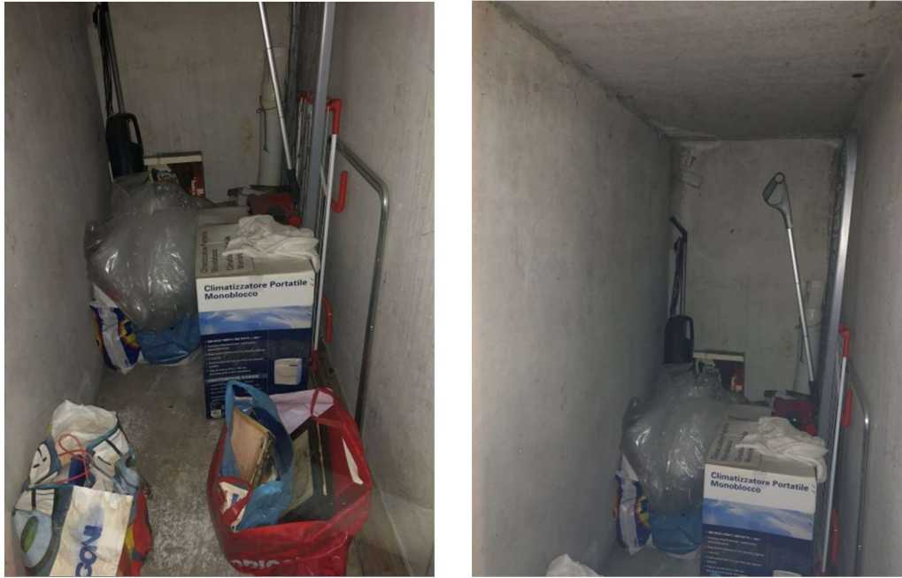
Viste interne del vano cantina il 25/01/2019
