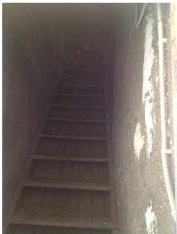
scala interna solaio
