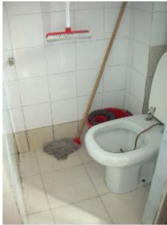
servizio 1 lato destro ingresso
