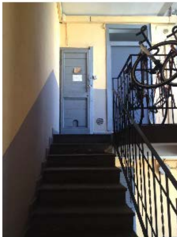
Porta accesso solaio
