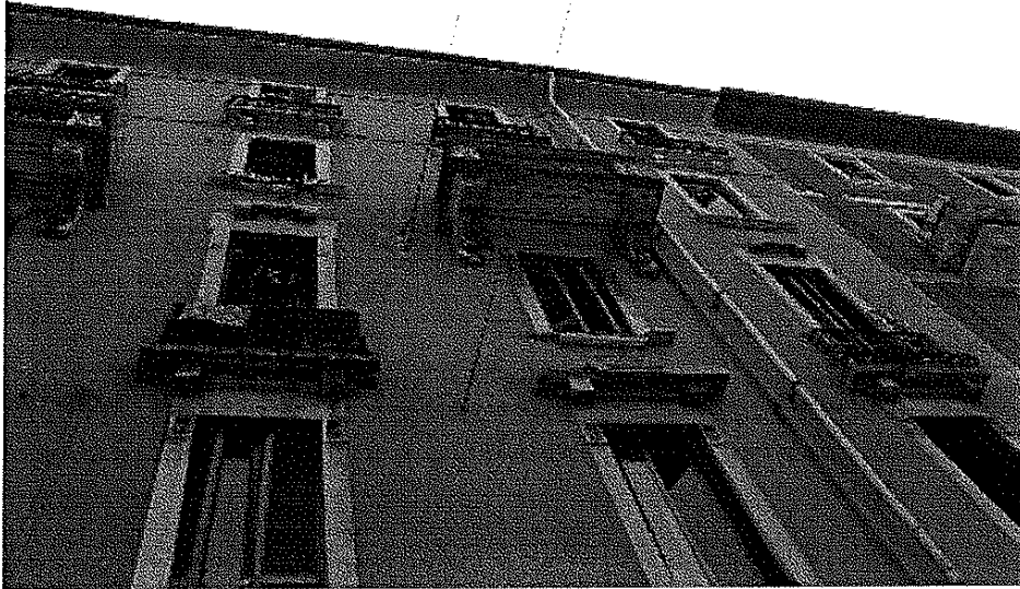
FOTO 1: MILANO, VIA PADOVA 82, vista fabbricato da via Padova
