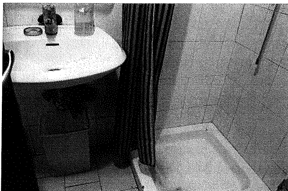
FOTO 8: MILANO, VIA PADOVA 82, bagno
