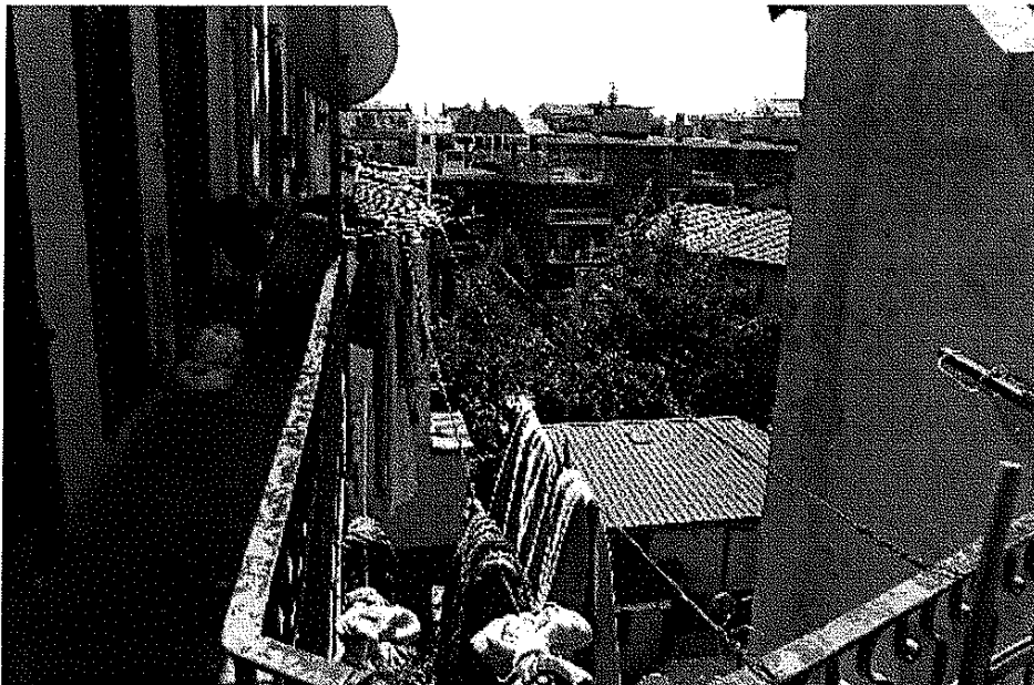
FOTO 4: MILANO, VIA PADOVA 82, ballatoio di accesso all'abitazione
