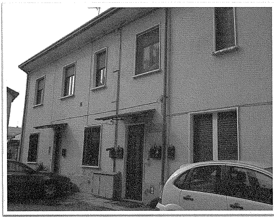
Vista dell'edificio dalla via Lucania.
