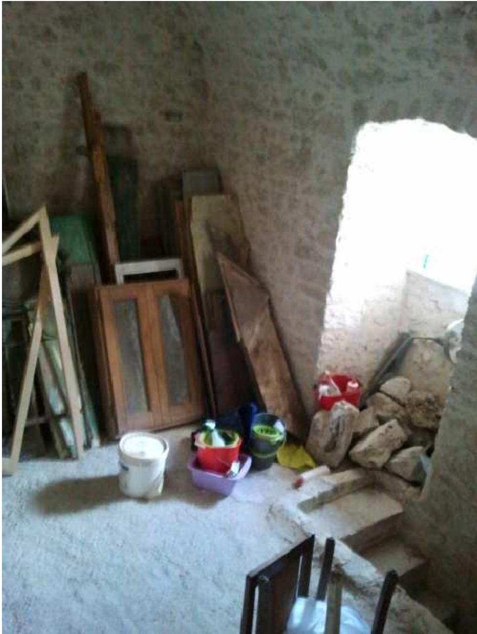
Vista del primo vano
