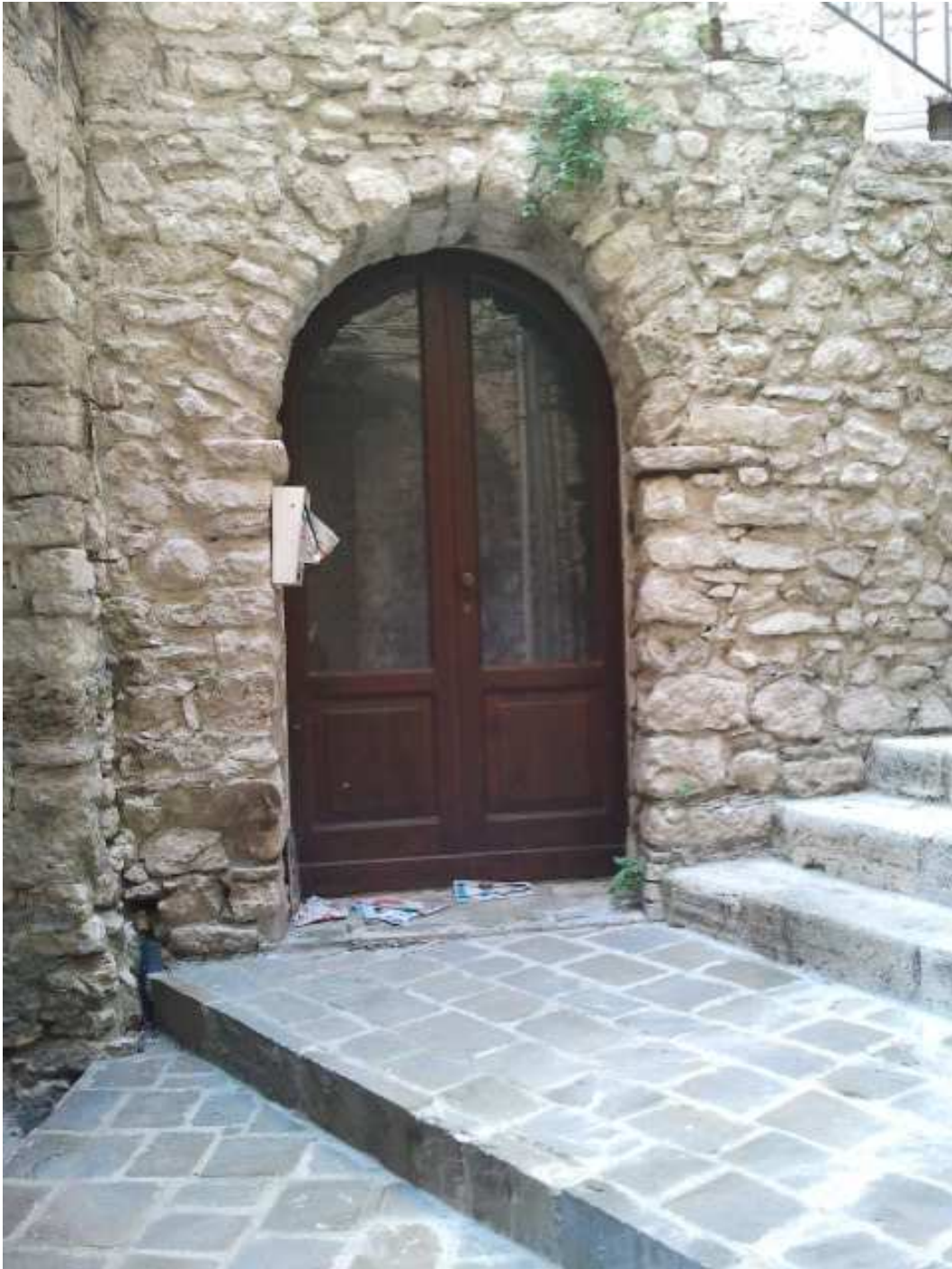
Vista dell'ingresso esterno
