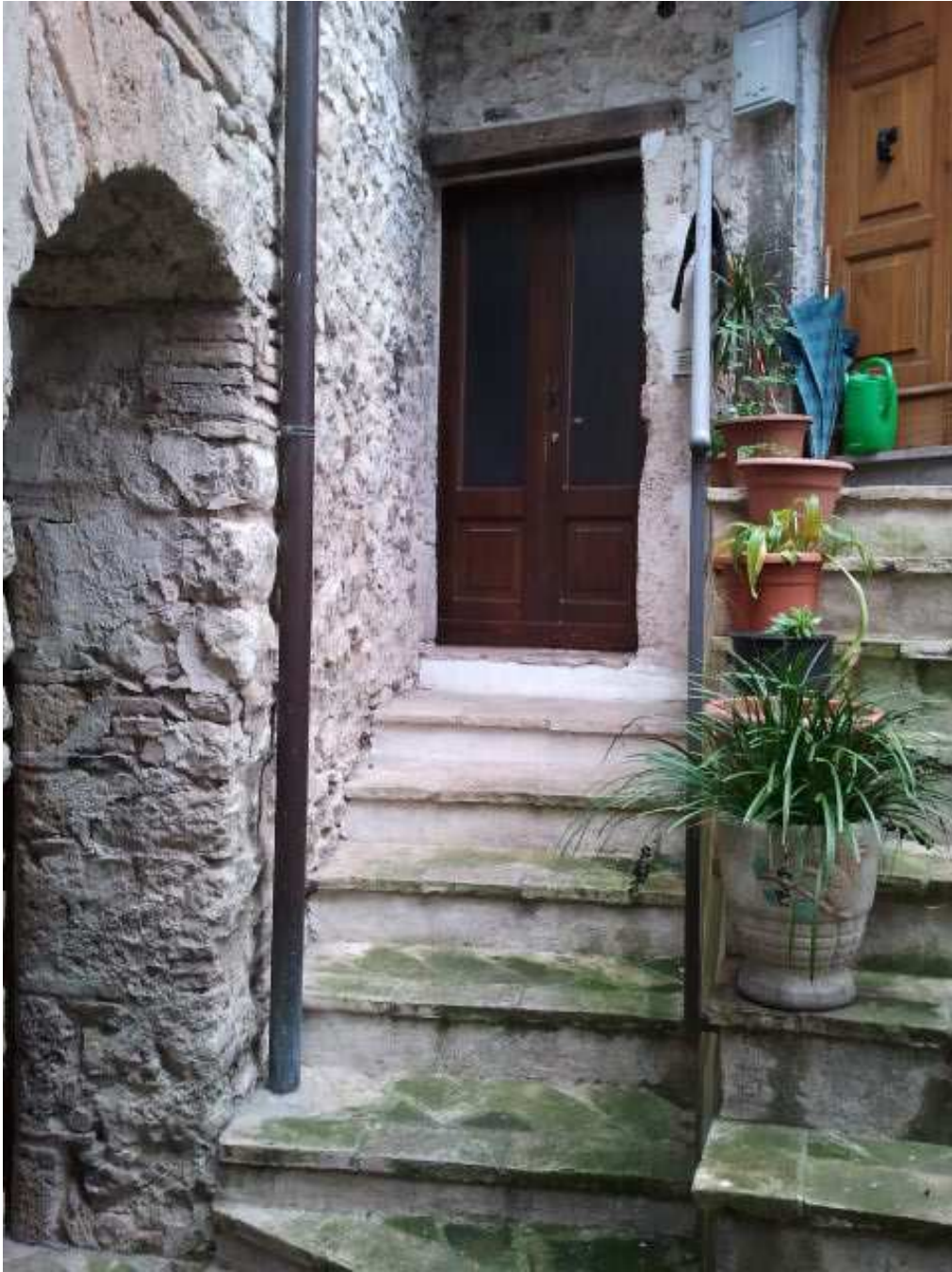
Vista dell'ingresso esterno
