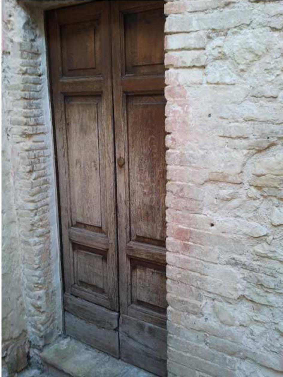
Viste dell'ingresso, con particolare del portone
