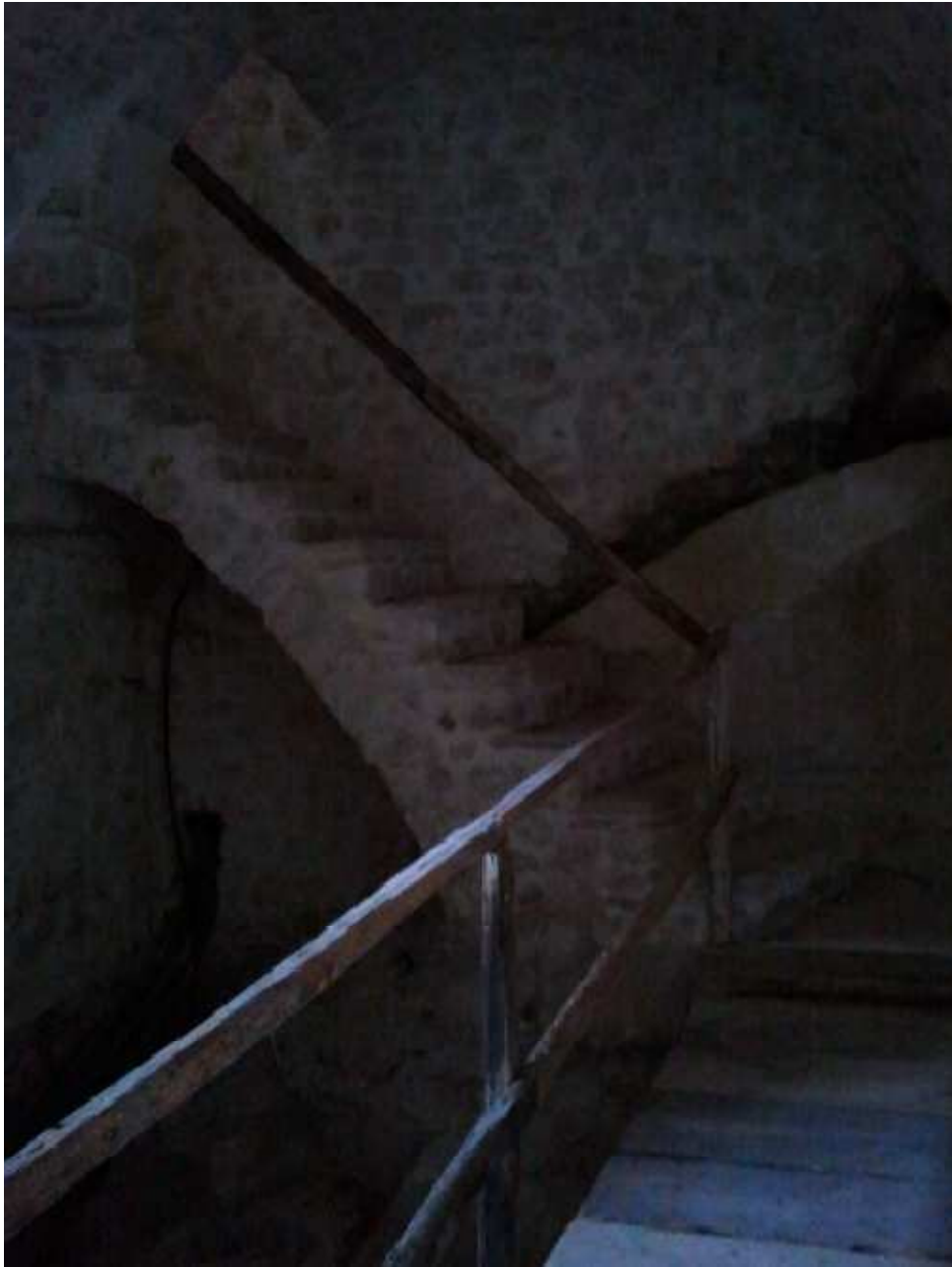
Vista del secondo vano con scale
